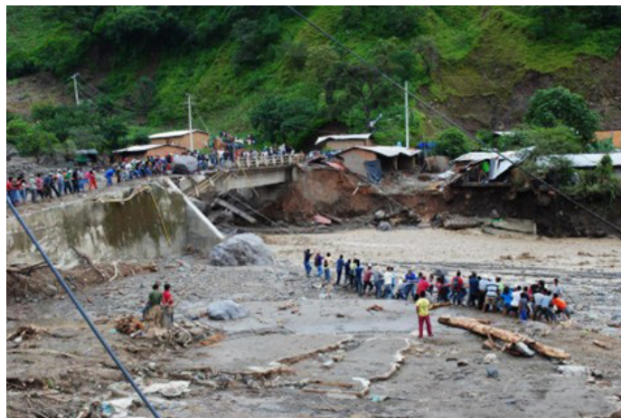
Personas de la comunidad removiendo una gran roca del puente. El terreno en primer plano estaba ocupado por viviendas antes del desastre. Fotografía de Ismael Díaz Solís
