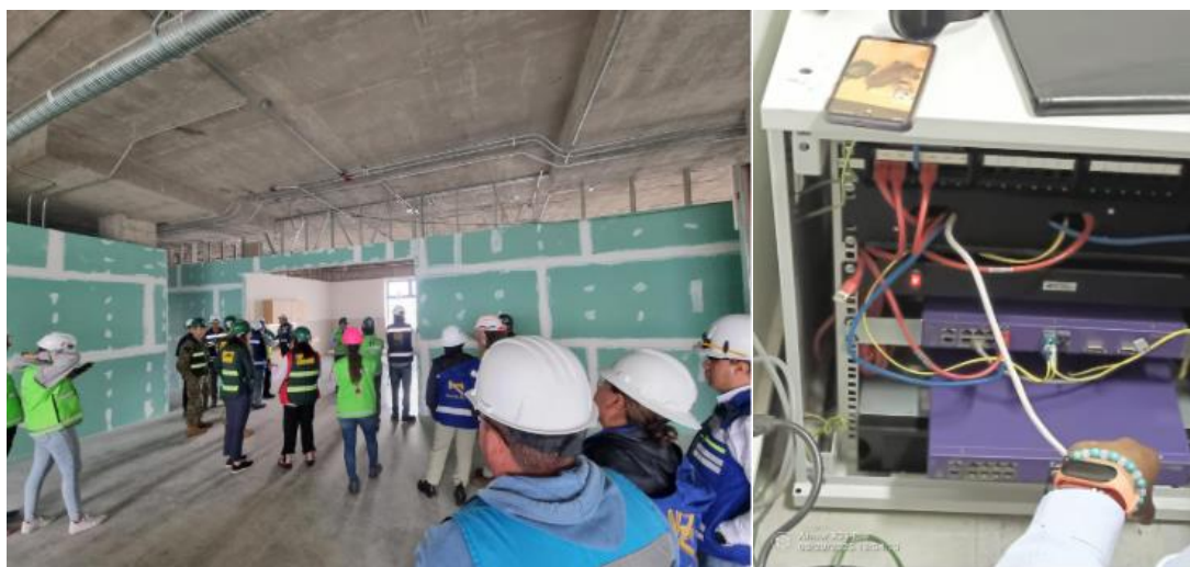
Visita al edificio de la Enaproc para revisión de los trabajos del cableado estructurado (izquierda). Mantenimiento en el cuarto de comunicaciones, cambio de switch por falla (derecha)
