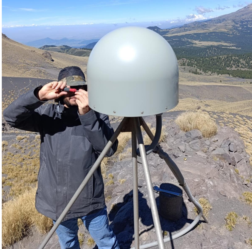
Mantenimiento al GNSS de una estación de monitoreo del volcán Popocatepetl
