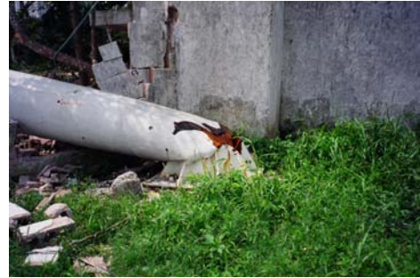
Figura 4.5 Falla de estructura con un anuncio espectacular en la carretera entre Mérida y Puerto Progreso
