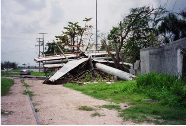
Figura 4.5 Falla de estructura con un anuncio espectacular en la carretera entre Mérida y Puerto Progreso
