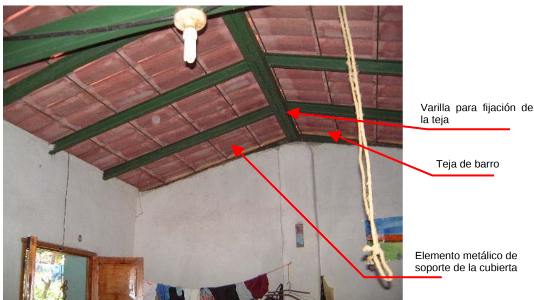
Figura 5.4 Características recomendadas para un techo de teja en una vivienda sujeta a vientos fuertes
