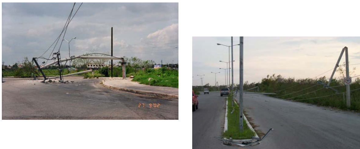
Figura 4.2 Daños observados en los postes de transmisión de energía eléctrica en el estado de Yucatán
