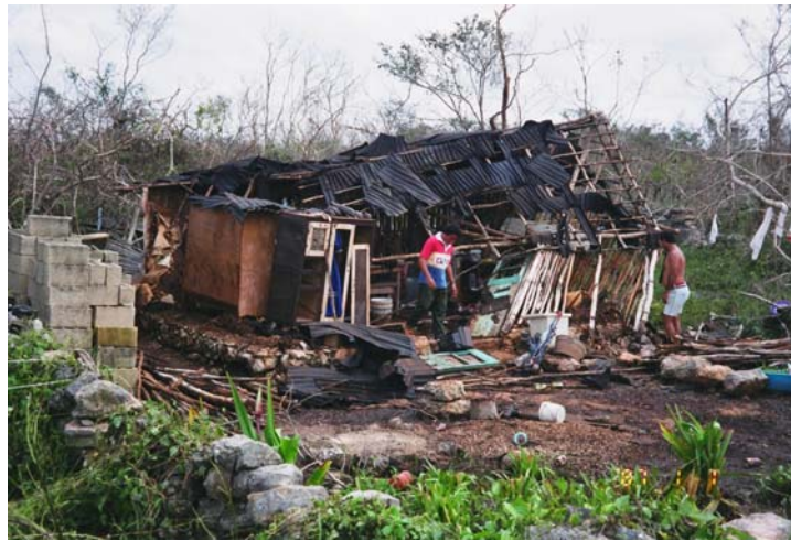
Figura 4.9 Falla de vivienda con tipología de la región, constituida a base de material precario en muros y techos
