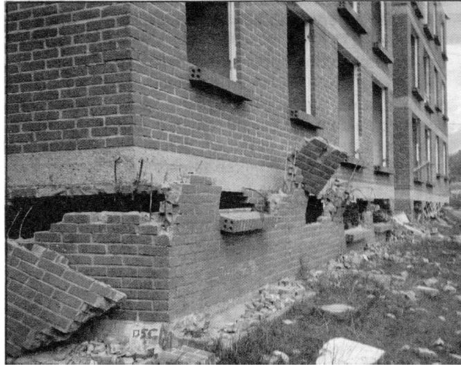
**Figura 1.8 Edificio de mampostería reforzada de 4 pisos. Colapso del primer nivel**
