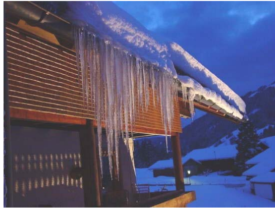
Figura 3.79 Peligro por carámbanos que pueden caer de un tejado
