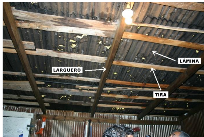
Figura B.2 Techo típico en las casas que más padecen las nevadas
