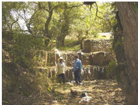
Figura 1.64 Presa de gaviones azolvada
