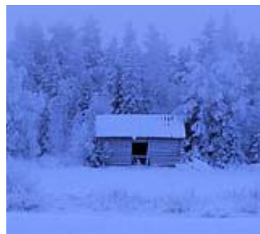
Figura 3.44 Nieve sobre un techo endeble
