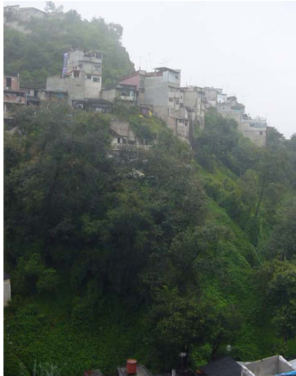
Figura 5.34 Ladera en la margen izquierda del río Xoloco, a la altura de la colonia A. Camacho
