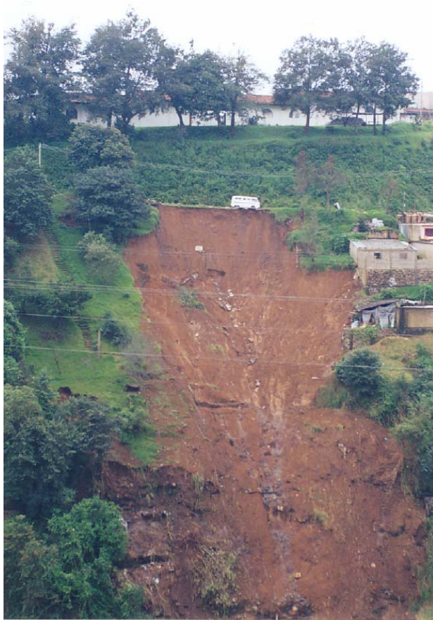
Figura 5.26 Vista frontal del deslizamiento contiguo a la carretera Perote-Teziutlán, en el tramo que cruza el barrio Xoloco
