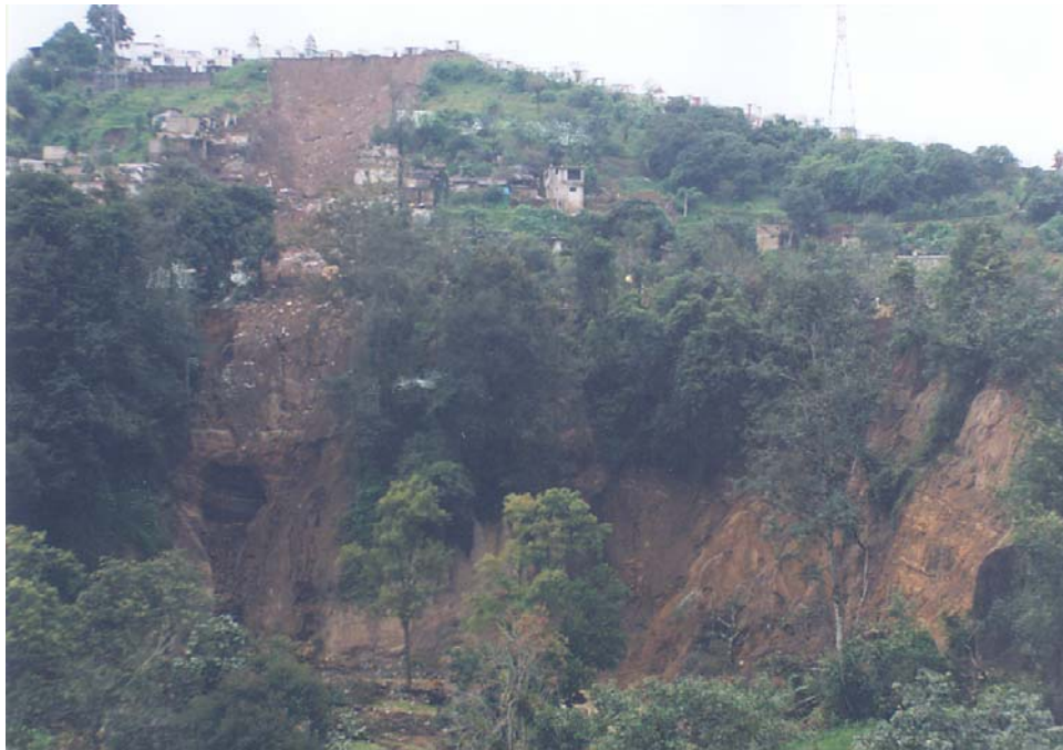
Figura 5.17 Vista del deslizamiento en La Aurora y la zona por donde cayó el flujo hacia el río Xoloco
