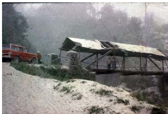
Figura 3.4 En regiones más cercanas al centro eruptivo, aparte de la ceniza volcánica, los fragmentos de mayor tamaño pueden producir perforaciones y severos daños a los techos, y a las vías de comunicación. Estas fotos muestran los daños producidos por las erupciones del volcán El Chichón en 1982, dentro de un radio de 10 km. A la izquierda, un techo perforado por líticos. A la derecha, un puente semidestruído por impactos. Fotos de S. De la Cruz
