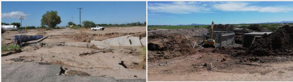
**Figura 2.57. Obras de reconstrucción del puente colapsado en la comunidad de Bacorehuis, Sinaloa. Fuente: Línea Directa y Debate**
