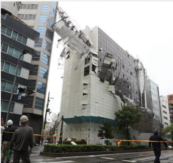
**Figura 7.12. Daños en un edificio después de la caída de un andamio como consecuencia de las fuertes rachas de viento por el tifón Jebi, en Osaka, Japón.** Fuente: 20 Minutos
