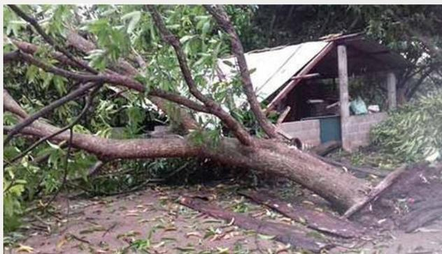
**Figura 2.190. Afectaciones en vivienda por la caída de árboles a causa de fuertes vientos.** Fuente: *El Orbe*
