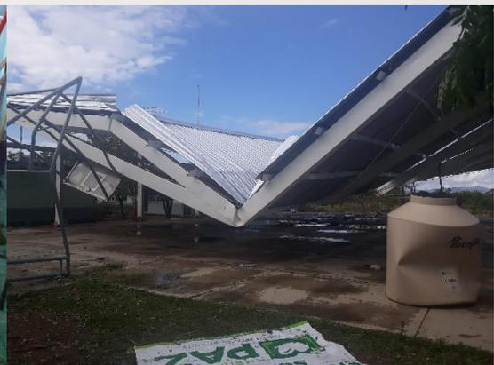
**Figura 2.95. Daño en techumbres del Cobaes 68, localidad Ojo de Agua de Palmillas, municipios de Escuinapa.**
