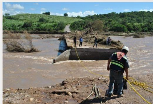
**Figura 2.106. Daños en puente La Batanga.**
