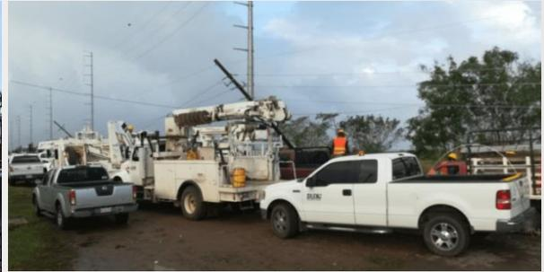
**Figura 2.108. Personal de CFE restablecen el cableado y los postes de luz afectados por el huracán *Willa*, en Sinaloa.**
