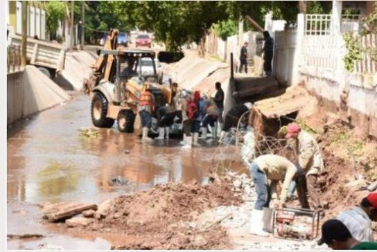
**Figura 2.35.** Cuadrillas de trabajadores del ayuntamiento limpian los cauces y refuerzan las paredes que fueron desprendidas en varios tramos por la fuerza del agua.
