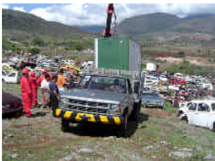
Estación Chilpancingo, maniobras de retiro
