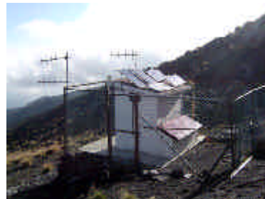
Estación sísmica Canario
