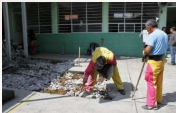
Figura 3.114. Reparación de plantel educativo.
