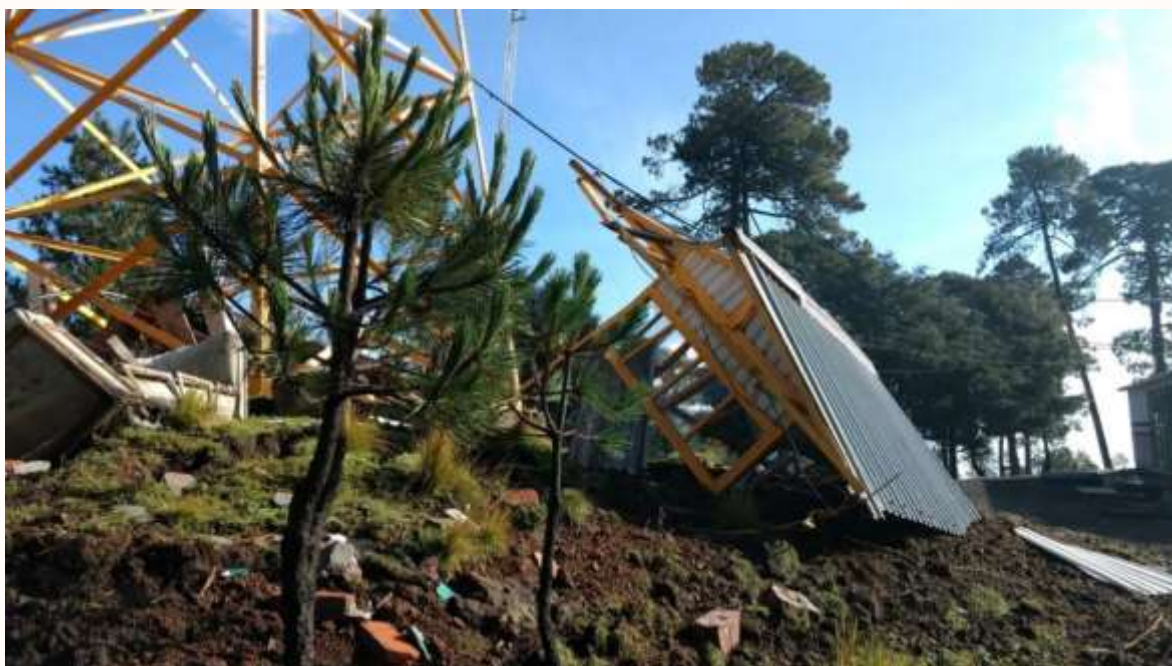
Figura 3.138. Afectaciones en las instalaciones del campamento forestal Cerro Panza. Fuente: CONAFOR, 2017
