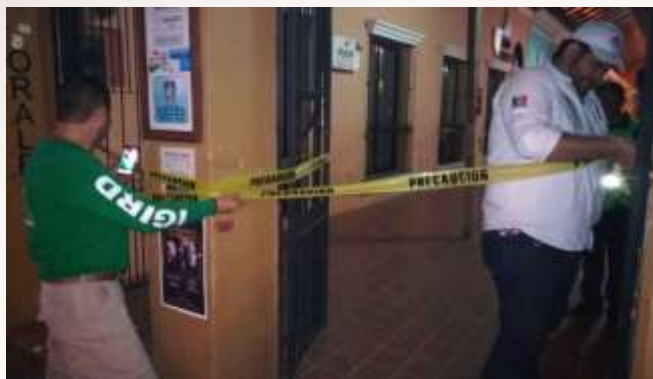
Figura 3.55. Dictaminación de daños por parte de especialistas. Fuente: Noticieros Televisa https://noticieros.televisa.com/ultimas-noticias/autoridades-chiapas-recorren-estado-sismo/
