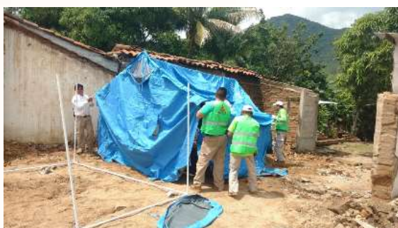
Figura 3.35. Instalación de vivienda temporal. Fuente: Secretaría de Protección Civil del estado de Chiapas
