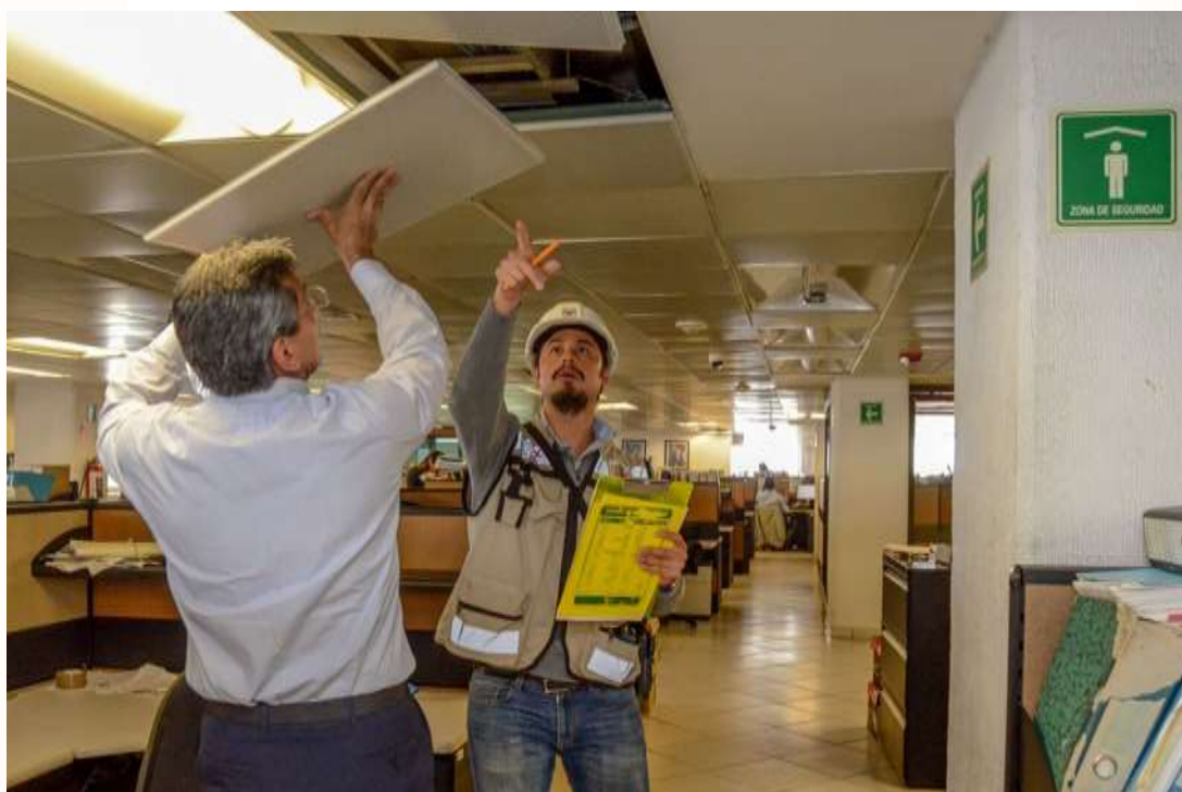
Figura 3.105. Expertos en la materia revisan la integridad de las edificaciones afectadas en la ciudad. Fuente: Vorágine en https://www.voragine.com.mx/2017/09/27/proteccion-civil-cdmx-dictamina-en-buenas-condiciones-edificio-central-la-sagarpa/
