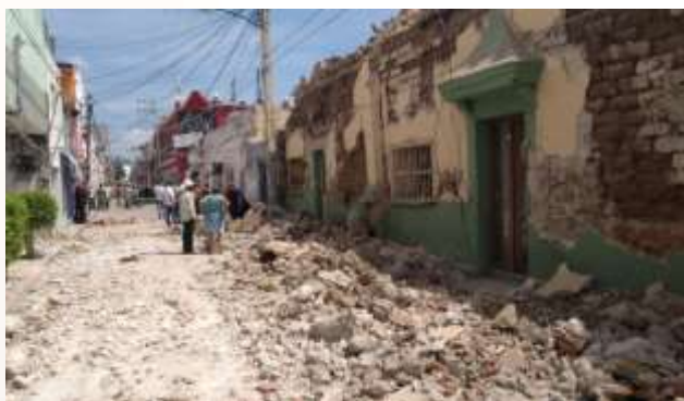
Figura 3.145. Destrozos del sismo en Jojutla. Fuente: Diario de México en https://www.diariodemexicousa.com/no-olviden-jojutla-el-municipio-m%C3%A1s-afectado-en-morelos-tras-sismo
