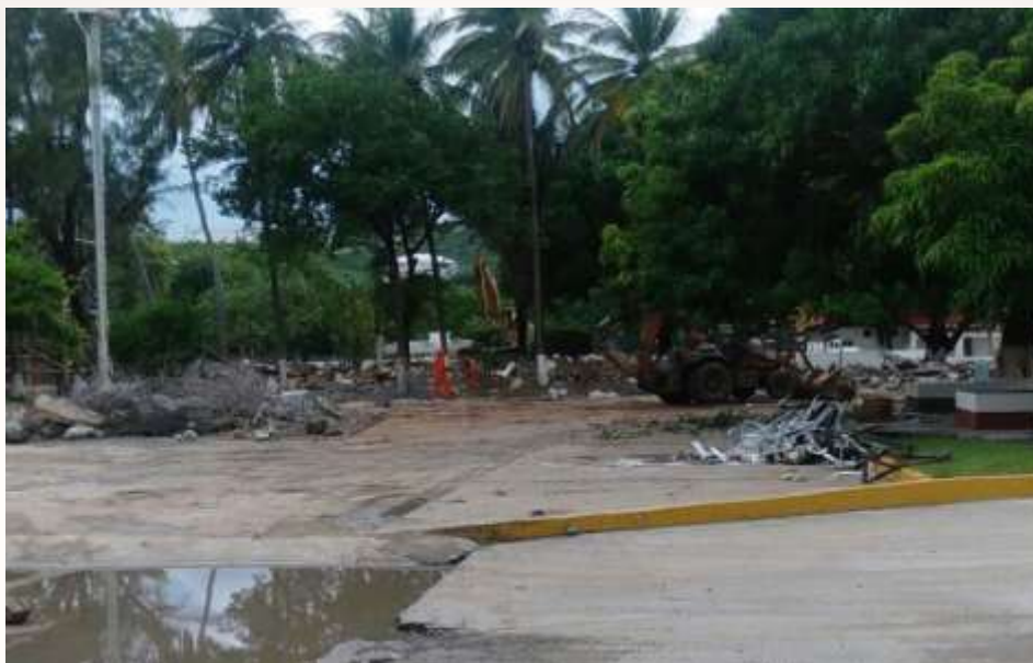
Figura 3.30. Remoción de escombros en el Astillero de Marina número de 20 en Salinas Cruz. Fuente: http://imparcialoaxaca.mx/istmo/67295/demuelen-edificios-historicos-de-salina-cruz-oaxaca/
