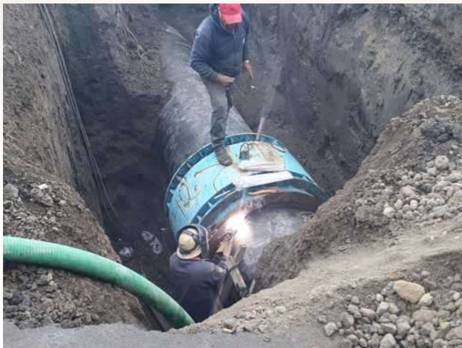
Figura 3.206. Reparación de la red hidráulica dañada en la entidad.
