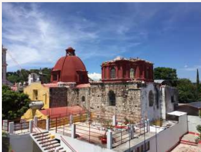
Figura 3.266. Cúpula colapsada de la iglesia San José. Fuente: El Heraldo, 2017 20
