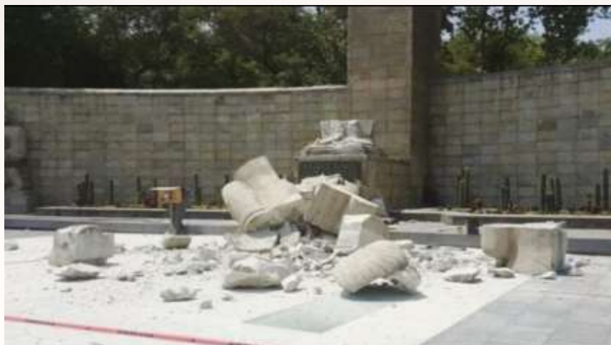
Figura 3.99. Varios monumentos de valor histórico presentaron deterioros, el Monumento a la Madre fue uno de los más notorios. Fuente: Informador.mx en https://www.informador.mx/cultura/Sismo-deja-graves-danos-en-recintos-culturales-e-historicos-20170921-0054.html
