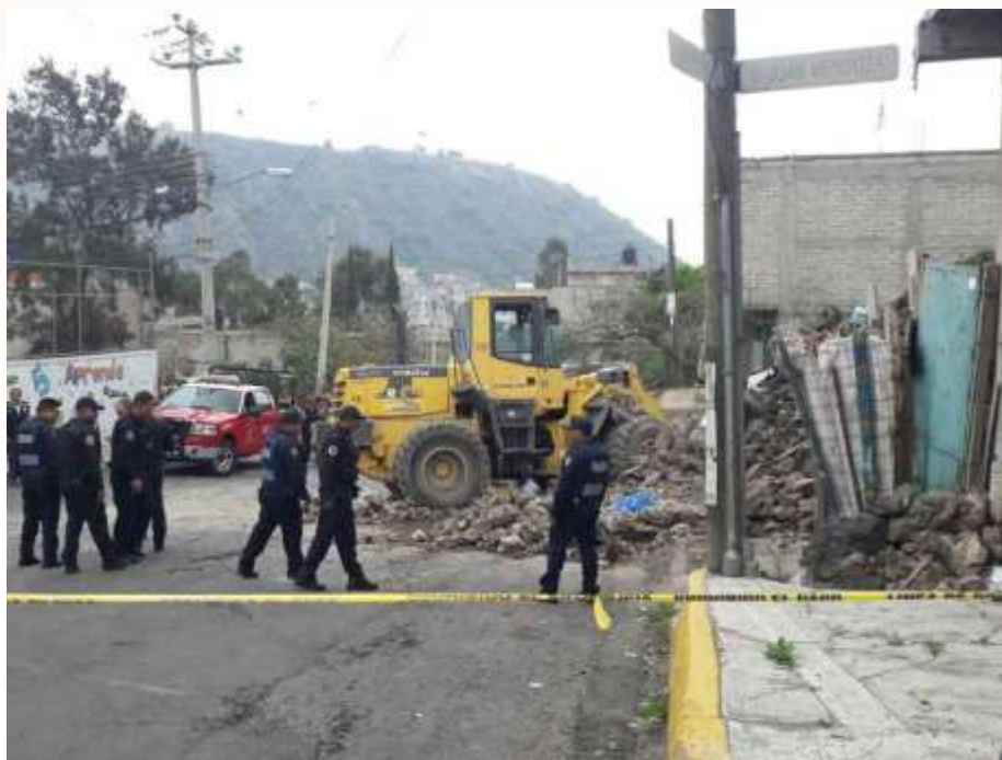
Figura 6.5. Derrumbe ocurrido en la alcaldía Iztapalapa, Ciudad de México. Fuente: Excelsior
