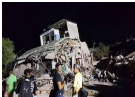
Figura 3.146. Casa destruida por el sismo. Fuente: Multimedia en http://www.multimedios.com/telediario/nacional/concluye-busqueda-victimas-morelos.html
