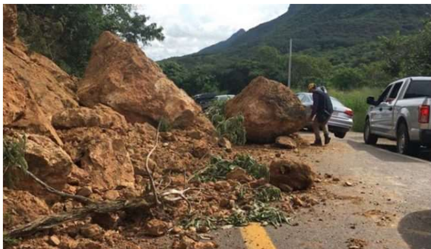
Figura 3.24. Derrumbes a causa del sismo en diversos tramos carreteros en Oaxaca. Fuente: https://www.nssoaxaca.com/2017/09/11/avanza-cao-en-los-trabajos-para-liberar-carreteras-afectadas-por-sismo/
