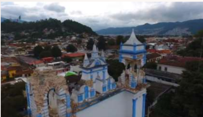
Figura 3.57. Daños en templo de Santa Lucía, municipio de San Cristóbal de las Casas. Fuente: Noticieros Televisa https://noticieros.televisa.com/ultimas-noticias/sismo-dana-25-iglesias-san-cristobal-y-chiapa-corzo-chiapas/
