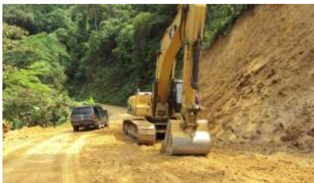
Figura 3.25. Trabajos para restablecer la comunicación en la carretera estatal.
