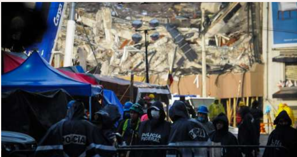
Figura 3.72. Edificio de Álvaro Obregón 286 con colapso total por el sismo del 19 de septiembre en donde perecieron 49 personas. Fuente: https://www.animalpolitico.com/2017/09/familiares-edificio-alvaro-obregon/
