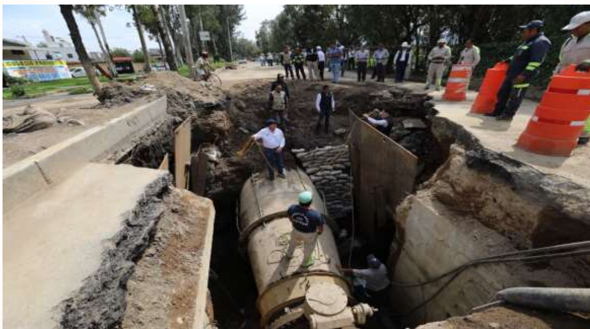
Figura 3.90. Acciones de reconstrucción en infraestructura hidráulica. Fuente: https://noticiasdelfdf.com/nota-ciudad-trabaja-gobierno-de-cdmx-en-reparar-fugas-de-agua-derivadas-de-sismo--avance-del-70-2017111025
