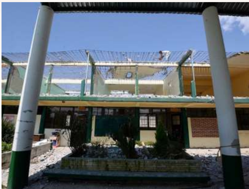
Figura 3.259. Trabajo de demolición del CBTIS 211 dañado por sismo. Fuente: Notimex, 2017
