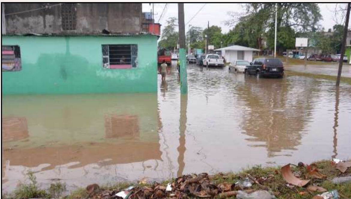
Figura 2.14. Viviendas dañadas por los efectos del huracán Beatriz .
