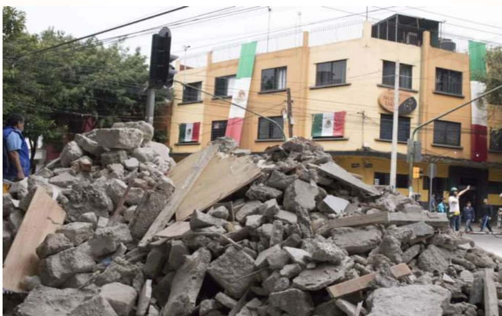
Figura 3.188. Los derrumbes fueron la consecuencia más evidente del sismo del 19 de septiembre. Fuente: Revista Proceso en https://www.proceso.com.mx/504362/crean-fideicomiso-fuerza-mexico-la-reconstruccion-tras-los-sismos
