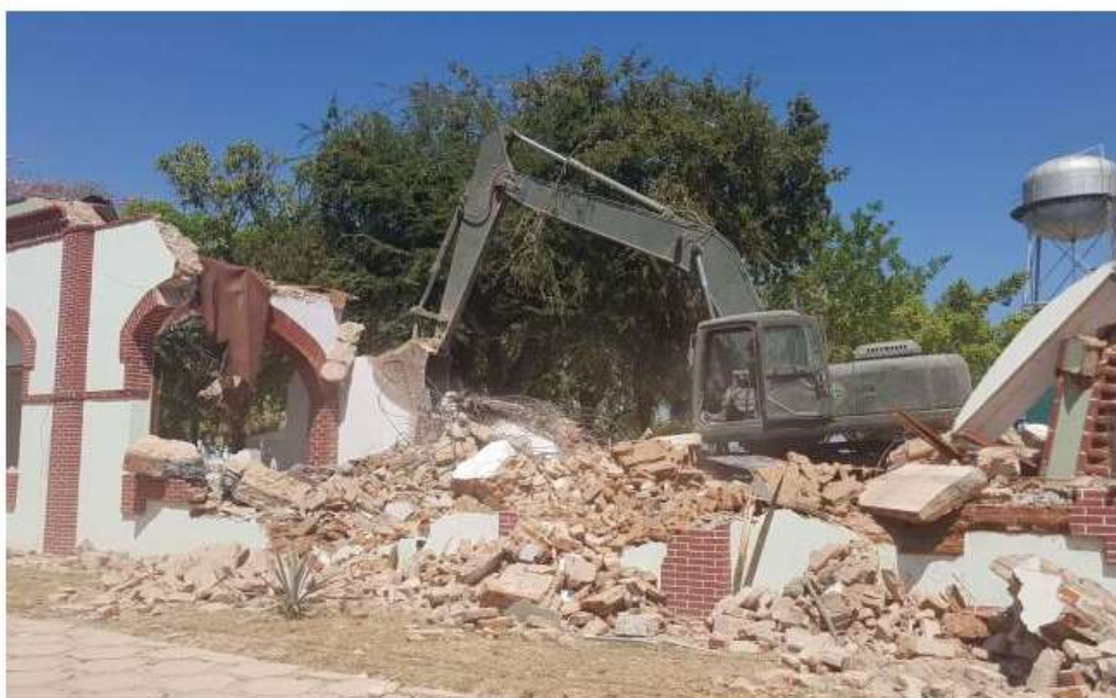
Figura 3.27. Demolición de las instalaciones del 98 batallón de infantería en Ixtepec.
