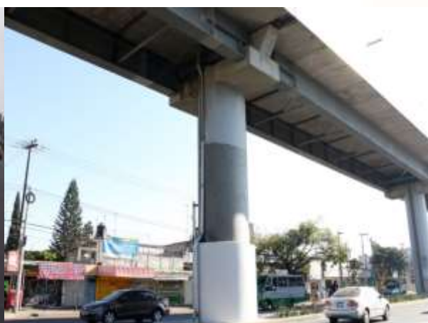
Figura 3.110. Columna tramo Nopalera-Olivos después de su reparación. Fuente: Sistema de Transporte Colectivo Metro en http://www.metro.cdmx.gob.mx/comunicacion/nota/concluyen-trabajos-de-reforzamiento-estructuras-de-l-12-danadas-por-el-sismo-del-19-de-septiembre
