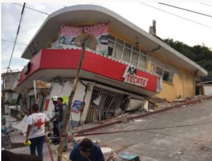
Figura 3.161. Muchos negocios en Morelos resultaron dañados por el sismo. Fuente: La Web del Centro en http://www.lawebdelcentro.info/primera-plana/cobertura-de-wdc-en-puebla-y-morelos/
