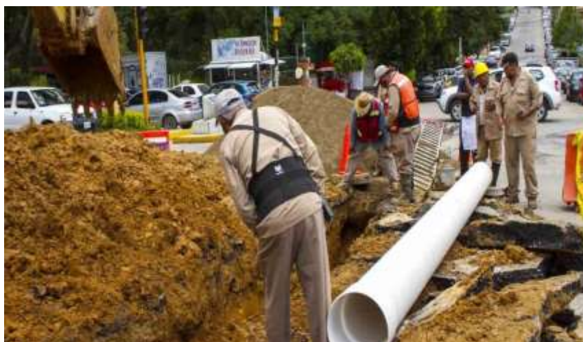
Figura 3.19. Labores de reconstrucción de la Infraestructura hidráulica en Oaxaca. Fuente: Oaxacahoy
