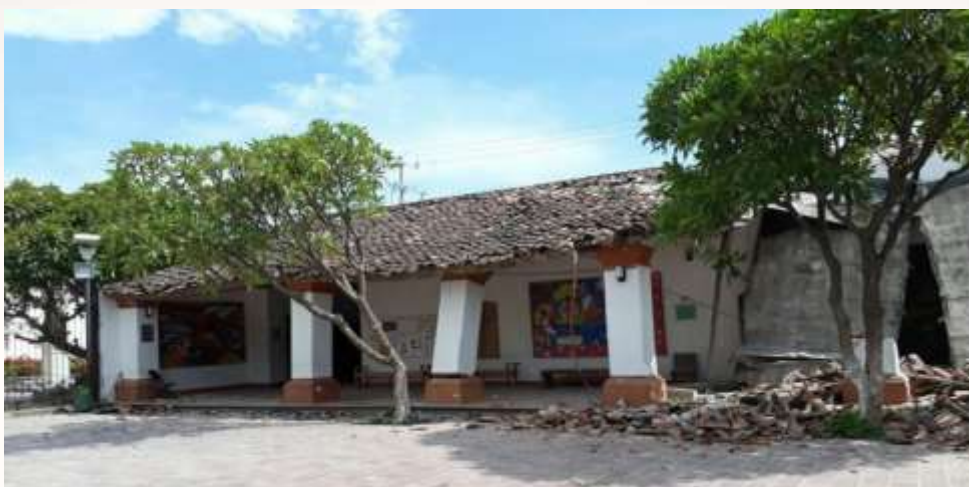
Figura 3.21. Casa de la Cultura de Juchitán del siglo XVIII afectada por el sismo. Fuente: Noticieros.televisa
