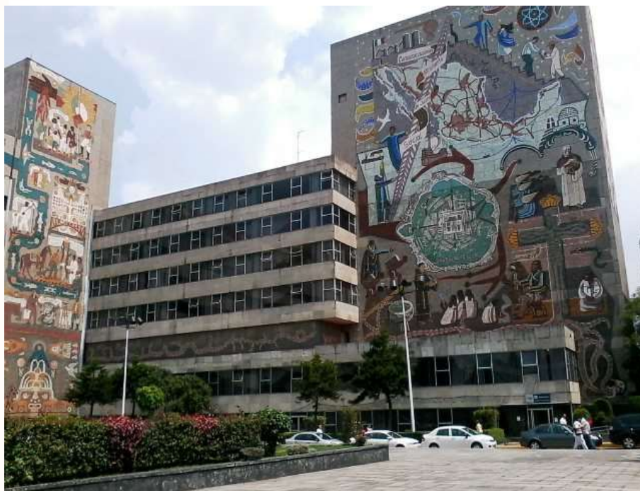
Figura 3.95. El edificio de la SCT podría ser demolido debido a los daños que presenta como consecuencia del sismo. Fuente: Arena pública en https://www.arenapublica.com/articulo/2017/10/03/7469/edificios-de-patrimonio-cultural-danados-por-el-terremoto
