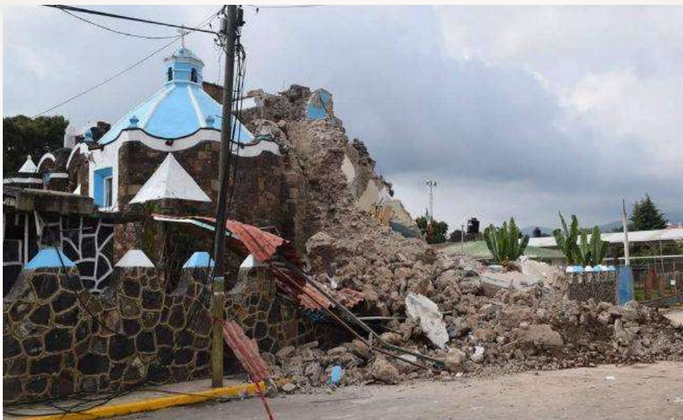
Figura 3.208. Iglesia devastada por el sismo. Fuente: Unión Edomex en http://www.unionedomex.mx/articulo/2017/09/20/ciudadanos/ocuilan-estado-de-mexico-asi-los-danos-tras-sismo
