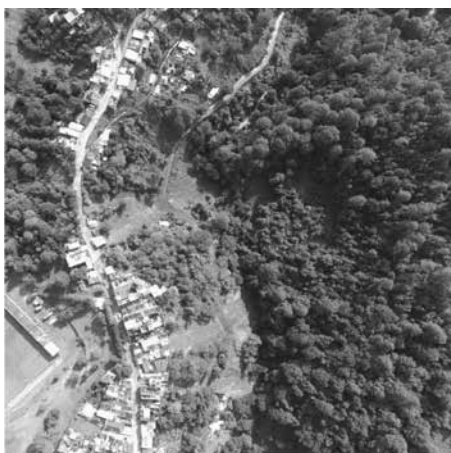
Figura 10 VISTA AÉREA DE DONDE SE OBSERVA EL CONTRASTE DE LOS DESLIZAMIENTOS SUCEDIDOS EN LA ZONA URBANA. EN LA LADERA OPUESTA DONDE NO EXISTE POBLACIÓN NO HUBO DESLIZAMIENTOS
