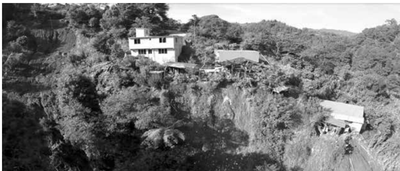
Figura 7 DESLIZAMIENTOS ASOCIADOS A LA PRESENCIA DE FOSAS SÉPTICAS, LAVADEROS Y BAJADAS DE AGUAS PLUVIALES DE TECHOS Y PATIOS DIRIGIDAS HACIA LA LADERA
