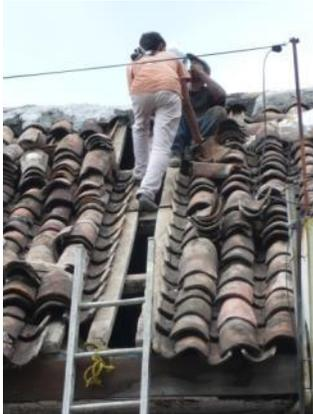
Figura 4.7 Reacomodo de tejas de arcilla para reparar techos
