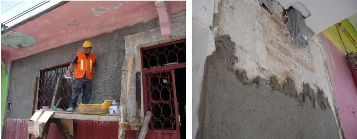
Figura 4.4 Reparación de muros con aplanado de mortero
