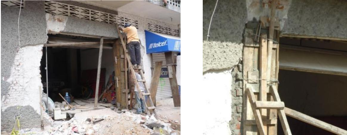
Figura 4.6 Aplanados y construcción de castillos adicionales
