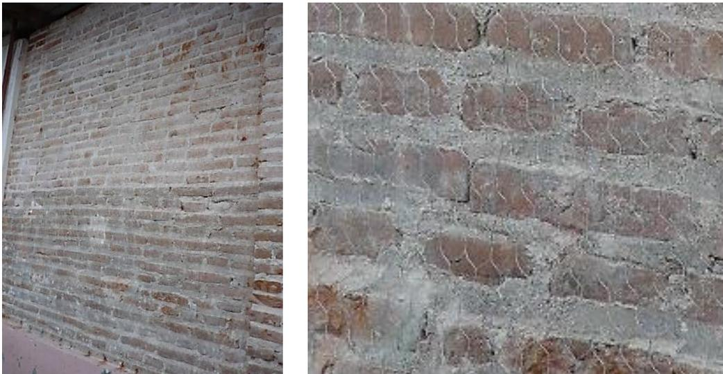
Figura 4.5 Colocación de malla hexagonal triple torsión (de gallinero) para aplanado de mortero
