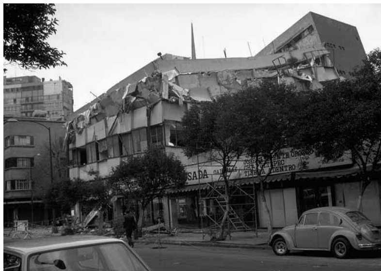
Figura 21 – Daños en edificio de departamentos ubicado en la Zona Rosa del Distrito Federal
