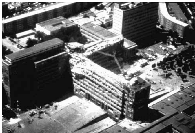
Figura 24 – Daños en el edificio de la Secretaría de Comunicaciones y Transportes
