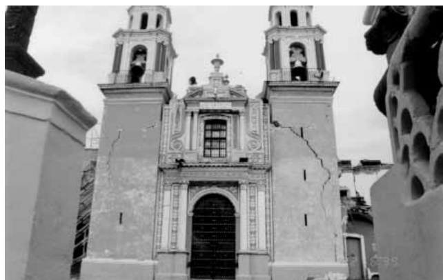
Figura 28 - Daño en los cuerpos de las torres de la Iglesia de Nuestra Señora de los Remedios en San Andrés Cholula (Alcocer et al., 1999)
