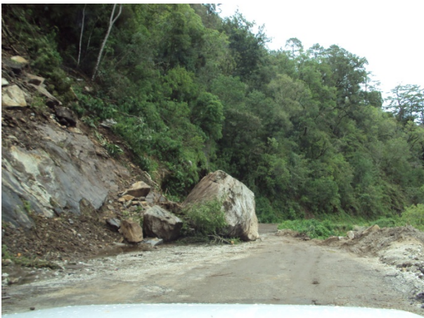
Afectaciones en caminos rurales
