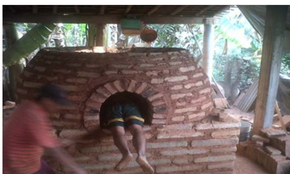
Figura 3.62 Reparación de hornos
