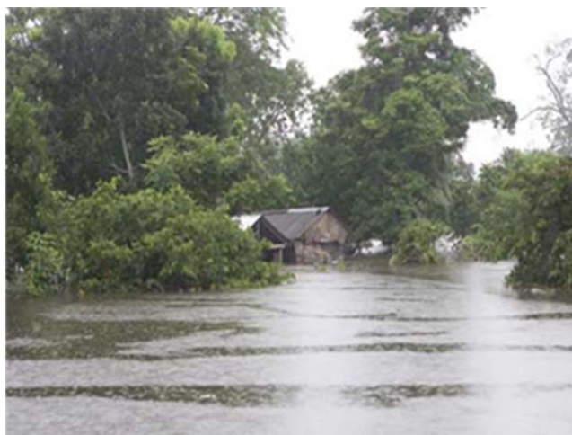
Figura 2.96 Vivienda afectada por Ernesto. Fuente: cuartoscuro.com
