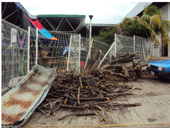
Figura 2.53 Daños en barda perimetral del mercado
