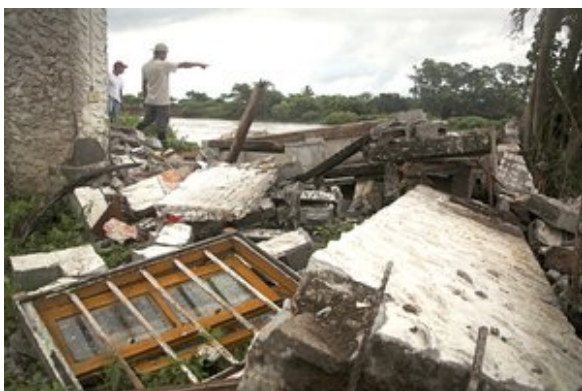
Figura 2.116 Vivienda afectada por el desbordamiento del río Jamapa.
