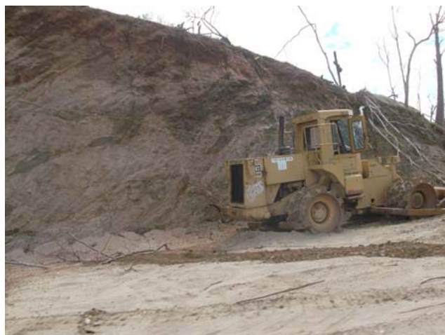
Figura 2.51 Acciones de rehabilitación de caminos
