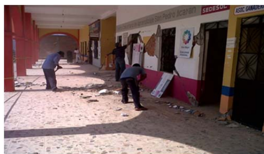
Figura 3.48 y 3.49 Labores de limpieza
