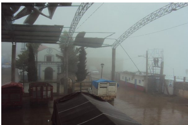
Afectaciones en el mercado de Puerto Escondido
