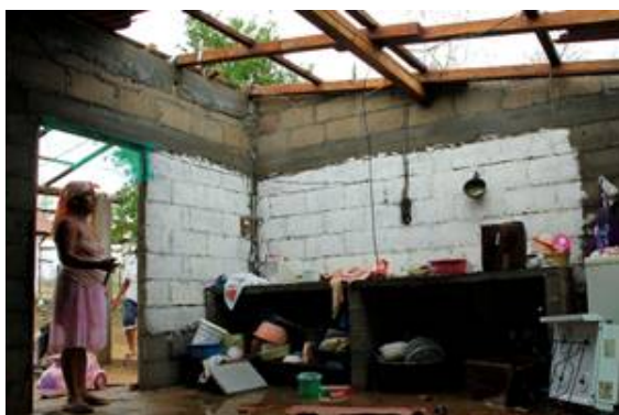
Figura 2.40 Daños en techos de lámina en viviendas
