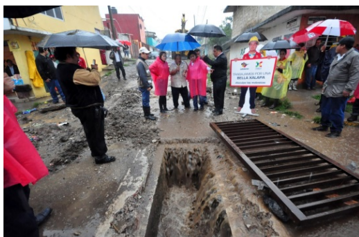
Figura 2.122 Desazolve de atarjeas en Xalapa
