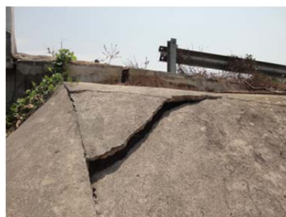
Puente Arroyo Frío
