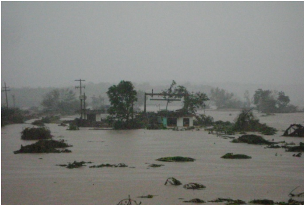
Pozo de bombeo en las riberas del río Colotepec
