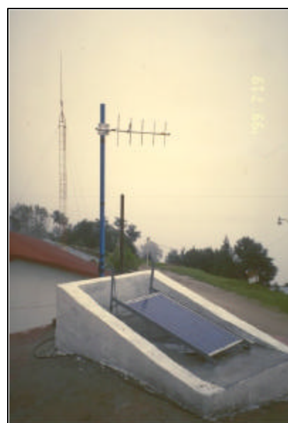
Figura 6.3 Celda solar y antena de radio, estación Ignacio Zaragoza Figura
