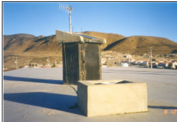
Figura 4.6 Estación Villafontana, VF-04
