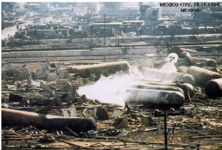
Figura 3.1 Resultados del incendio y explosión de contenedores de gas LP en San Juan Ixhuatepec, México, el 19 de noviembre de 1984 (Tudelft, 2001)
