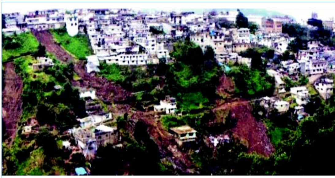
En esta fotografía se puede observar cómo un flujo destruyó algunas construcciones que estaban en la ladera en la colonia Juárez, en Teziutlán, Puebla.
