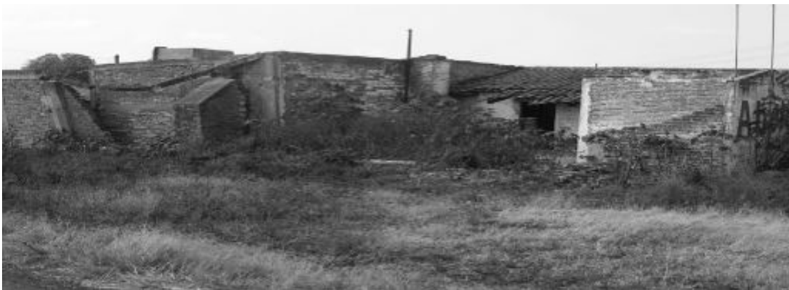
Vivienda dañada en el municipio de Abasolo debido al fenómeno de hundimiento regional
