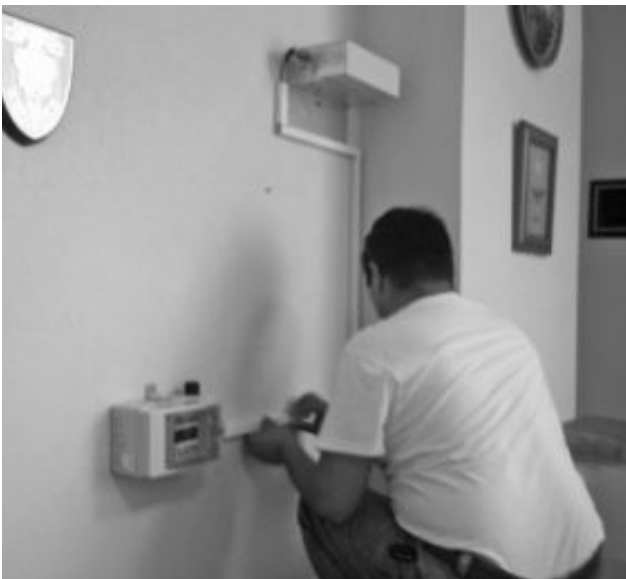
Instalación de estación acelerográfica en CGPC.
