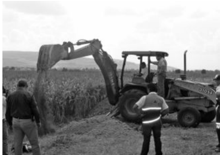
Pozos a cielo abierto excavados en predios que han sido afectados por el fenómeno de hundimiento y agrietamiento del terreno
