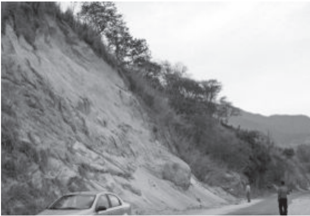
a) Deslizamiento ocurrido en la carretera Ometepec-Huajintepec, municipio de Ometepec, Guerrero
