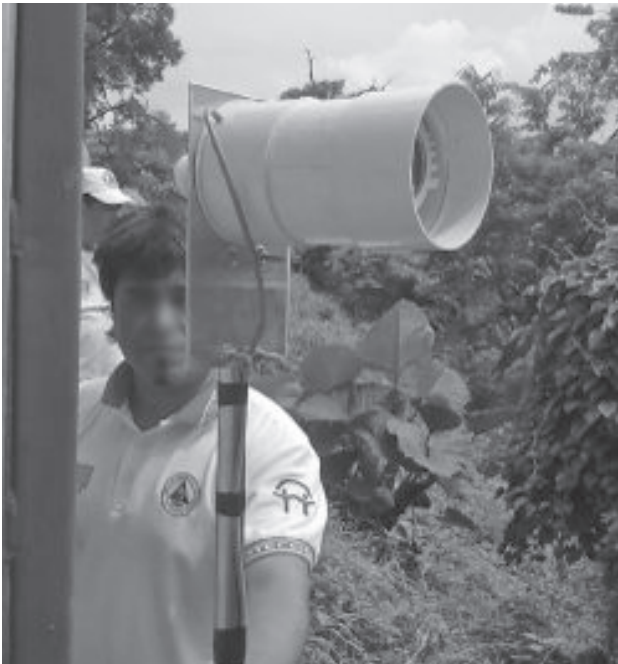
Instalaciones de Estaciones de Nivel con Radar.
