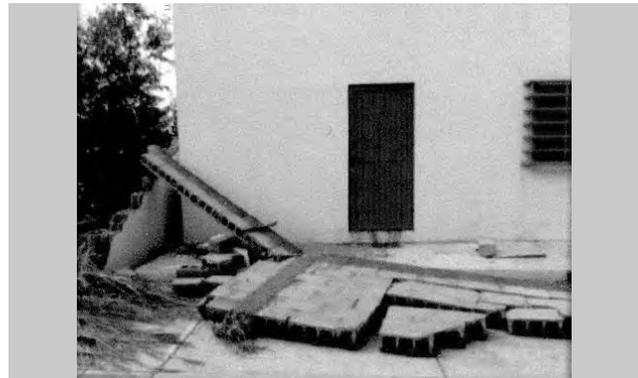
**D. Caída de barda de mampostería hecha de bloques huecos de concreto que estaba confinada con castillos y dalas.**
