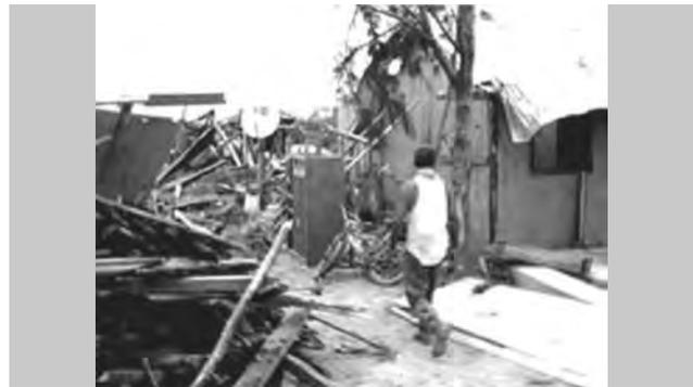
**Figura 2.319 Daños en vivienda construida de material endeble.**
