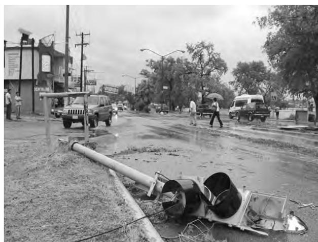
Figura 2.340 Daños en semáforos a consecuencia de los fuertes vientos.
