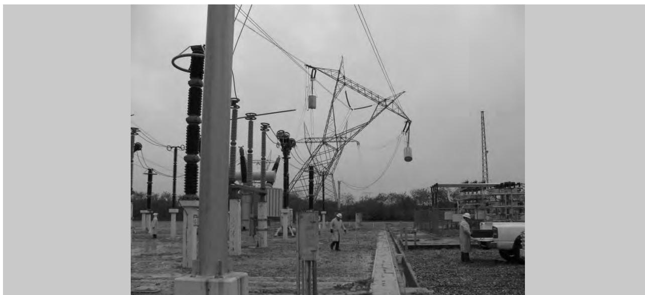
**Figura 2.336 Estructura afectada a consecuencia de los fuertes vientos.**
