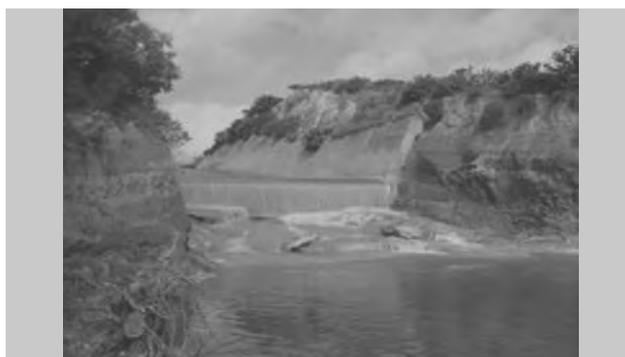
b) Ruptura de losa en tanque de amortiguamiento El Nogalito
