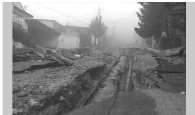
Figura 2.366 Tuberías de agua potable y otros servicios colapsados por la erosión
