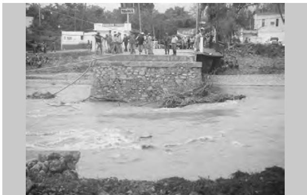
**Figura 2.334 Puente afectado en el municipio de Hidalgo**
