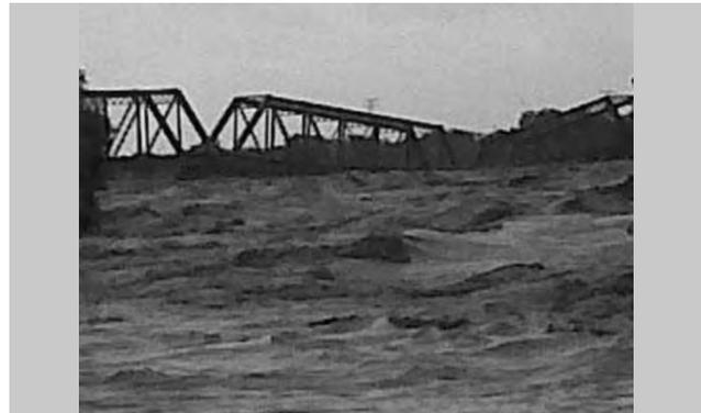
**Figura 2.396 Colapso de puente a su cruce sobre el Río El Pabillo (Fuente: Milenio en línea)**
