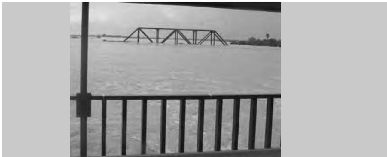
**Figura 2.393** Puente rebasado por el tirante del agua en el Río Salado
