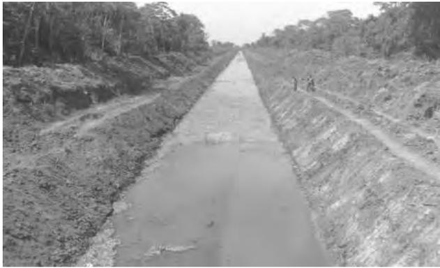
**Figura 2.238 Limpieza y desazolve del dren W 63+000, en la zona de La Chontalpa**
