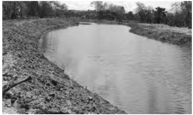
**Figura 2.237** Limpieza y desazolve del arroyo Reforma, en el municipio de Jalpa de Méndez
