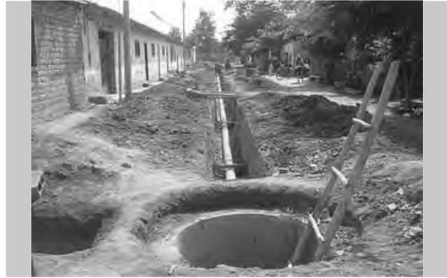
Figura 2.179 Desatolt y rehabilitación de alcantarillado
