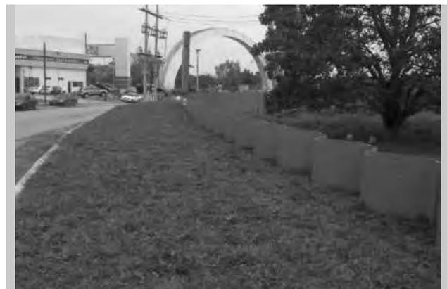
Figura 2.233 Obras de tablestacado en la margen izquierda del puente Carrizal IV
