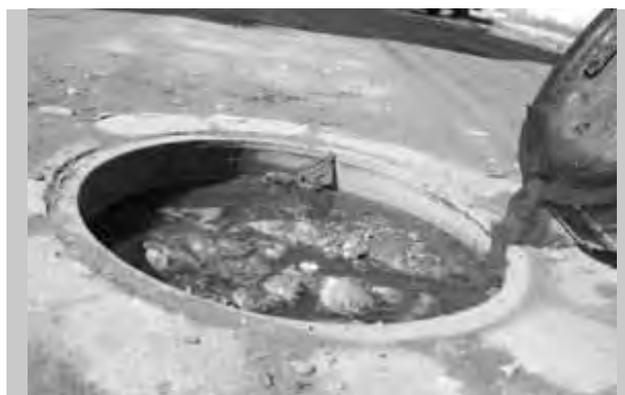
**Figura 2.266 Alcantarillas azolvadas por arena de costaleras y residuos sólidos**
