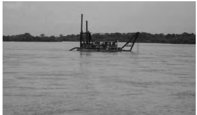
**Figura 2.241 Dragado del cauce piloto del río Samaria, en la zona de El Pastal**
