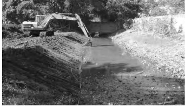
**Figura 2.235** Limpieza y desazolve del dren de aguas pluviales, en la ciudad de Tacotalpa
