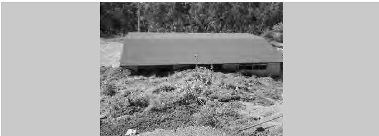
**Figura 2.135** Plantel afectado por los deslizamientos de laderas
