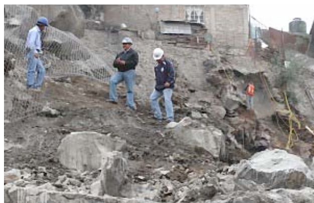
Figura 3.2 Deslizamiento del 16 de septiembre en Magdalena Contreras (Fuente: El Universal)
