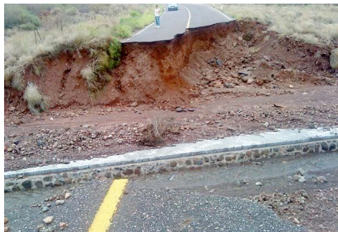
Figura 2.99 Corte carretero en el camino San Carlos - Tinajas
