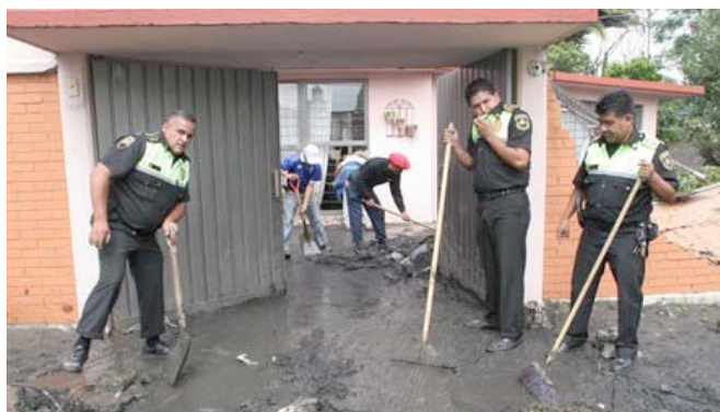
Figura 2.22 Personal de la ASE en labores de limpieza y remoción de escombros
