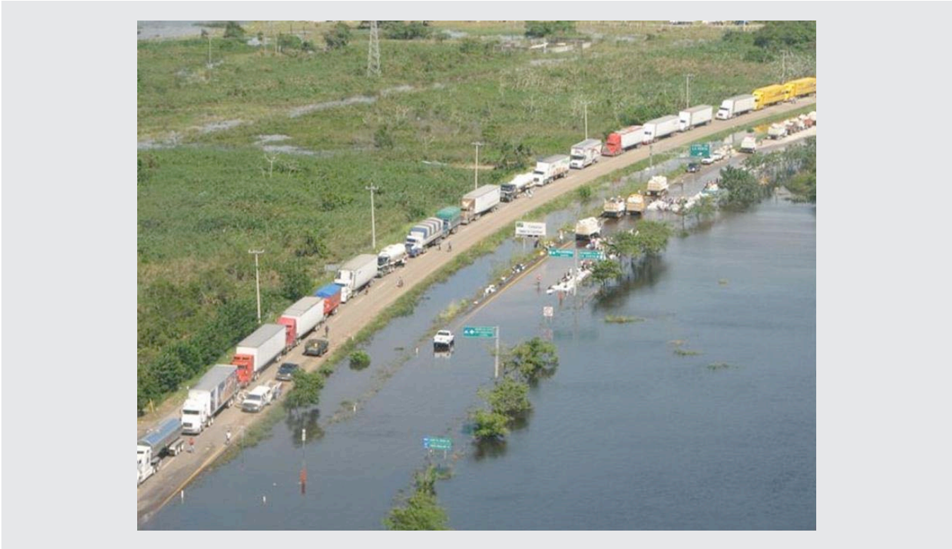
Figura 2.147 Efectos derivados de los daños en la infraestructura carretera (Fuente: SCT)
