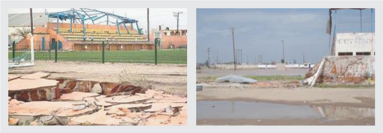
Figura 2.69 Daños en instalaciones deportivas Fuente: Periódico El Sudcaliforniano
