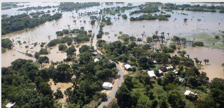
Figura 2.168 Daños en infraestructura carretera del estado de Veracruz a consecuencia de las intensas lluvias e inundaciones (Fuente: Ayuntamiento de Las Choapas)
