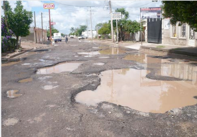
Figura 2.105 Daños en avenida Juan de la Barrera
