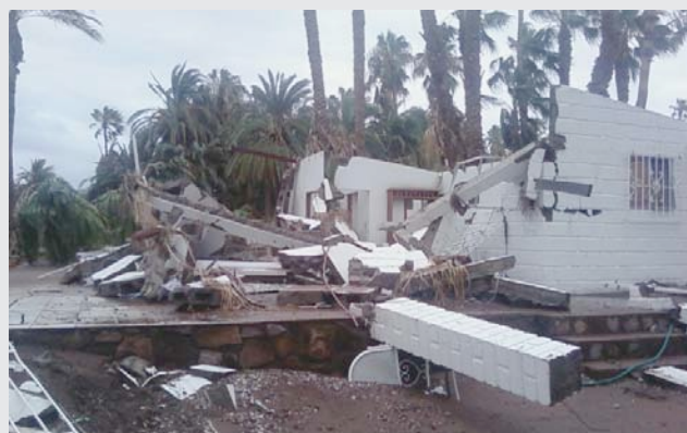
Viviendas afectadas en la localidad de H. Mulegé
