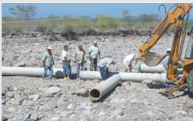
Acciones de restauración en acueducto Palo Verde, Santa Rosalía
