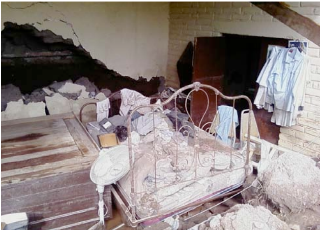
Figura 2.65 Pérdida de enseres en vivienda con daño total en el municipio de Mulegé
