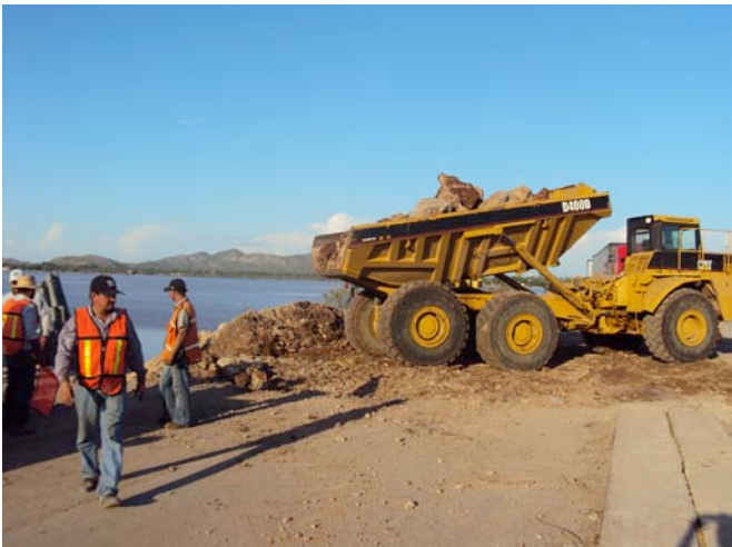
Figura 2.102 Maquinaria utilizada para atender daños en infraestructura carretera
