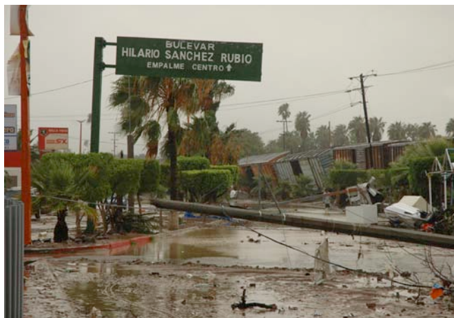
Figura 2.104 Postes caídos a consecuencia del impacto del huracán Jimena
