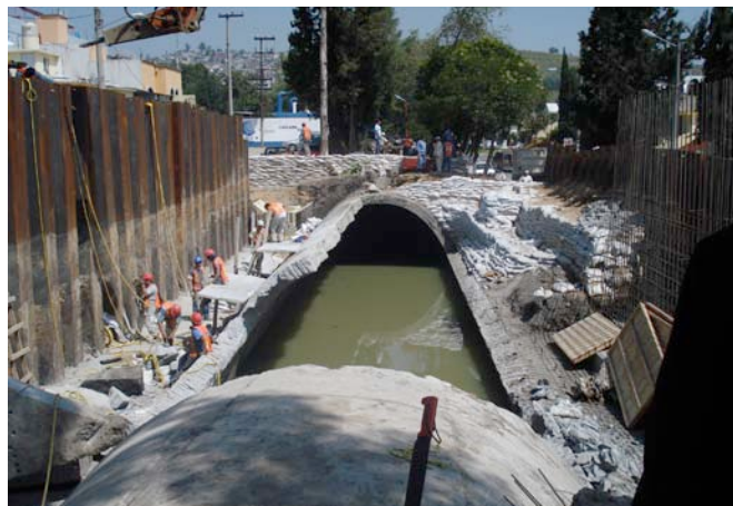
Figura 2.36 Trabajos de reparación en el Emisor Poniente
