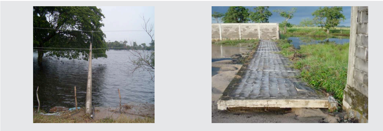
Figura 2.148 Daños en infraestructura eléctrica e instalaciones de la Comisión Federal de Electricidad
