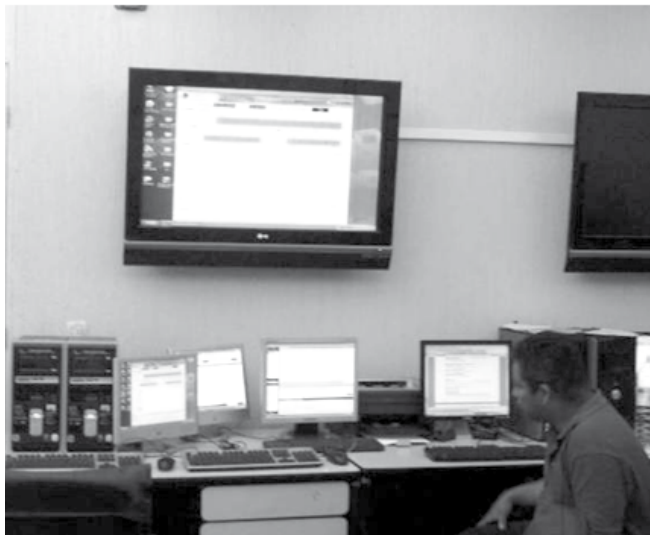
Puesto central del sistema de alerta contra inundaciones de Acapulco, Guerrero
