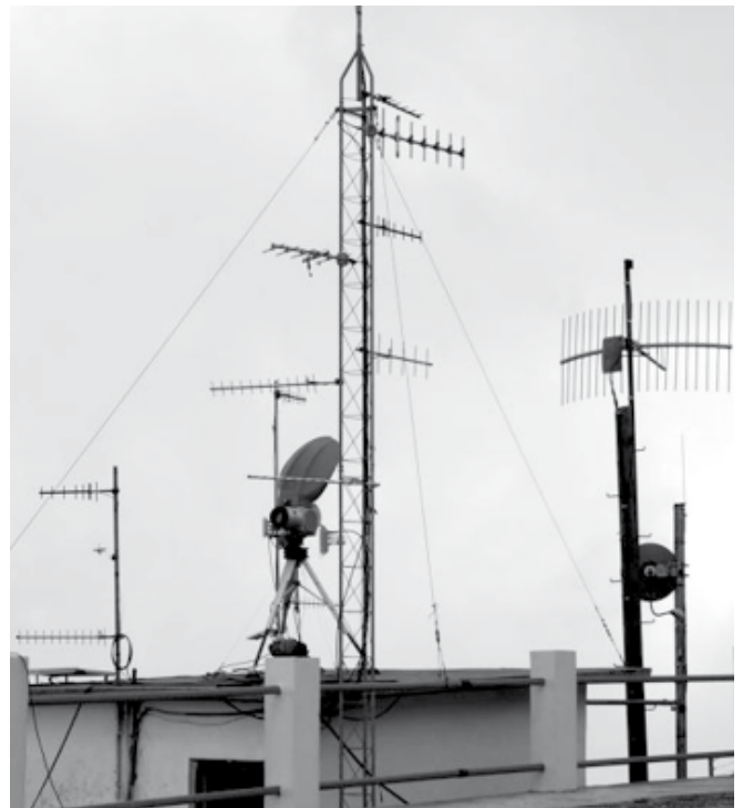
Estación repetidora Altzomoni
