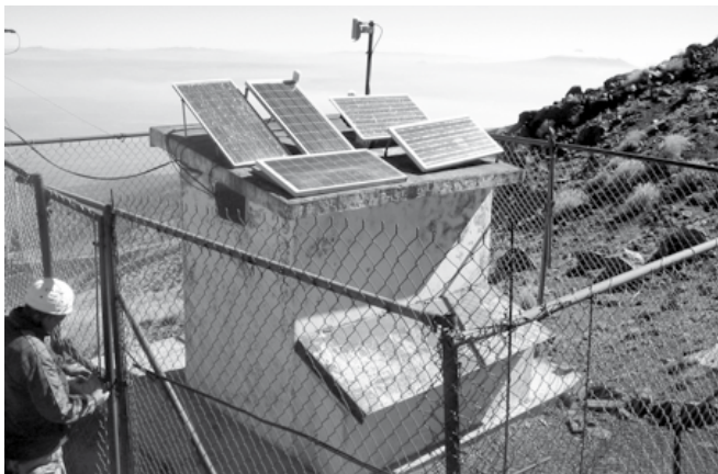
Estación sísmica Canario
