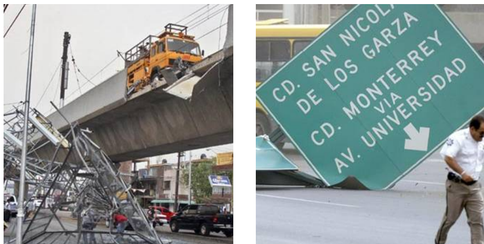
Figura 2.230 Daños ocasionados por los fuertes vientos del 18 de marzo en la zona metropolitana de la ciudad de Monterrey
