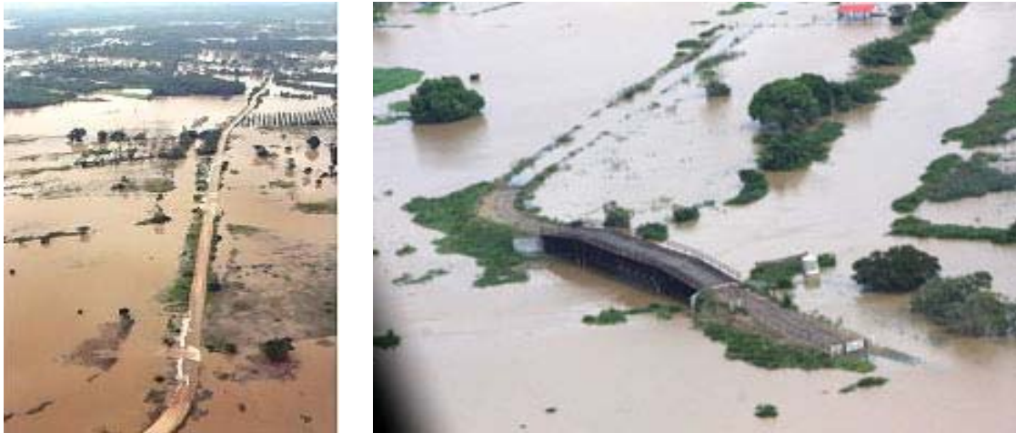
Figura 2.103 Infraestructura carretera afectada por las lluvias e inundaciones ocurridas del 19 al 22 de septiembre en el estado de Veracruz
