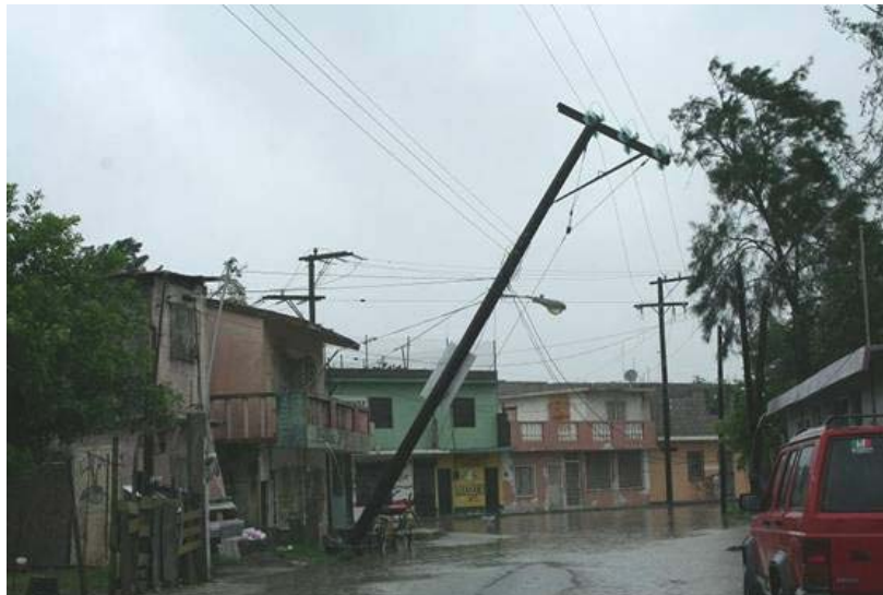
Figura 2.27 Daños en infraestructura eléctrica
