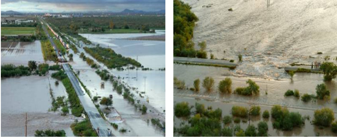
Figura 2.85 Daños en carreteras en el municipio de Huatabampo
