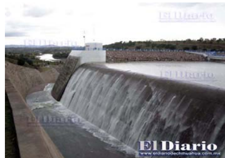
d. Presa Abraham González
