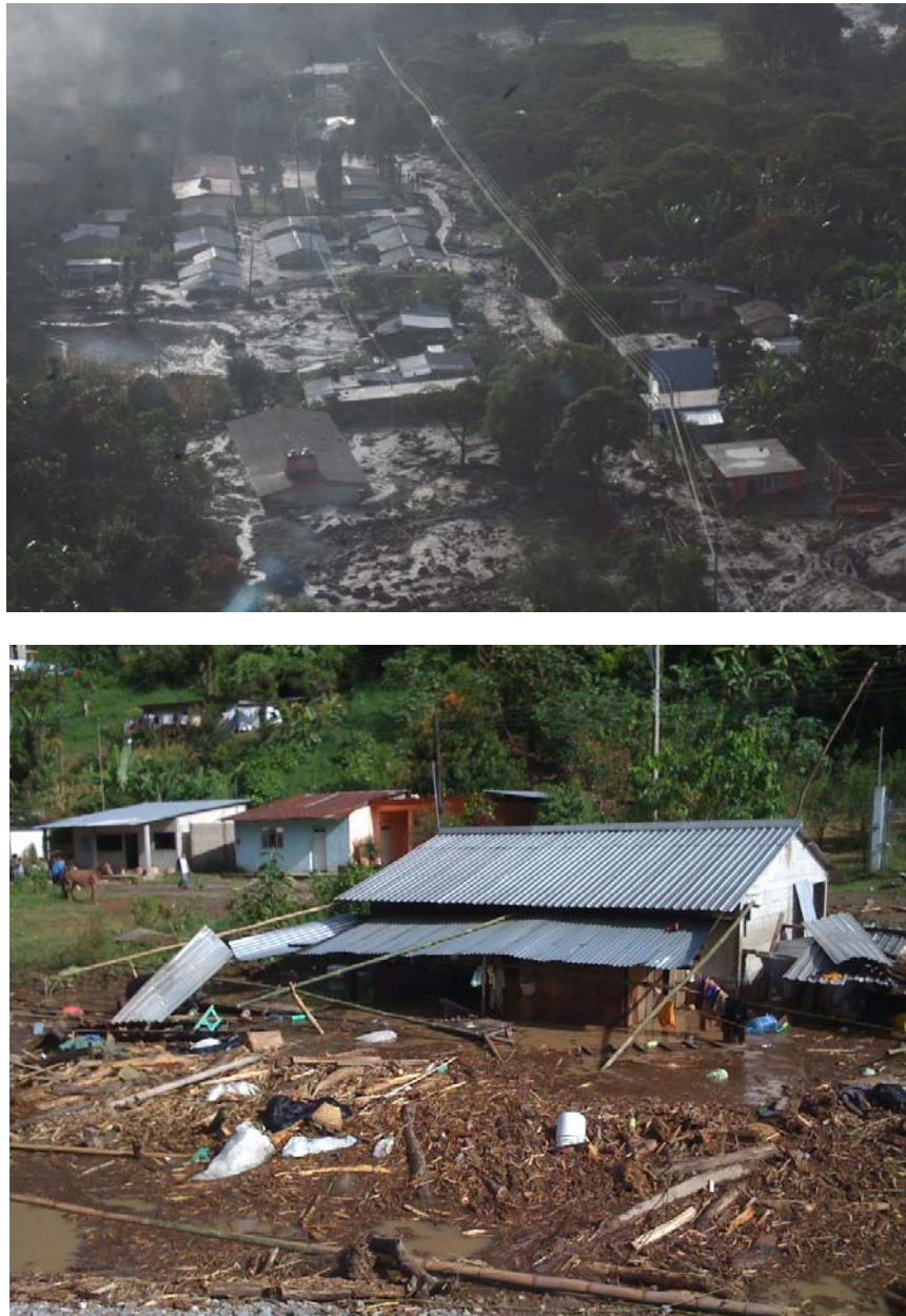
Figura 3.8 Afectaciones en viviendas y escuelas de Barranca Grande
