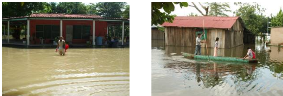
Figura 2.138 Viviendas inundadas de materiales de construcción distintos
