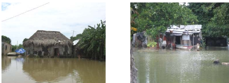
Figura 2.139 Viviendas afectadas por la inundación
