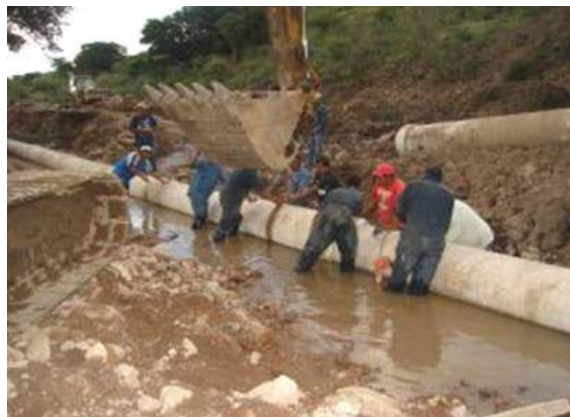
Figura 2.68 Acciones de reparación de líneas de conducción en el municipio de Parral
