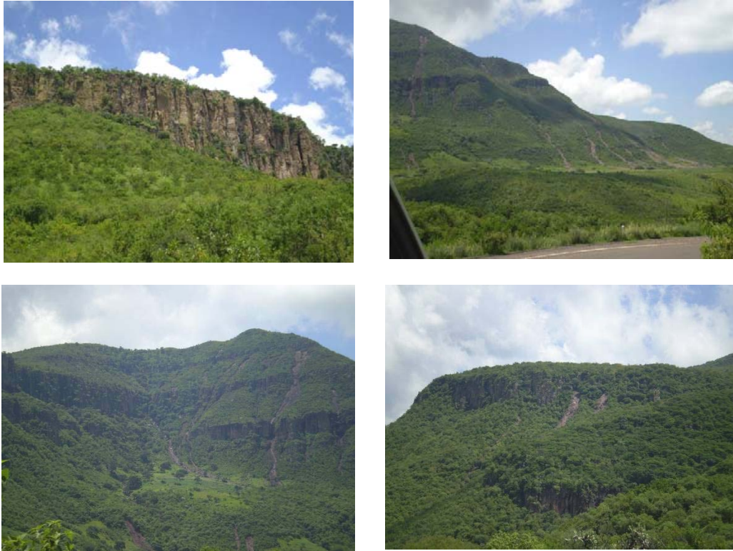
Figura 2.36 Formación de caídos al pie de los taludes
