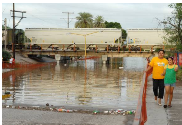
F. Agua estancada en el dren Las Ánimas después del flujo de agua en el mismo
