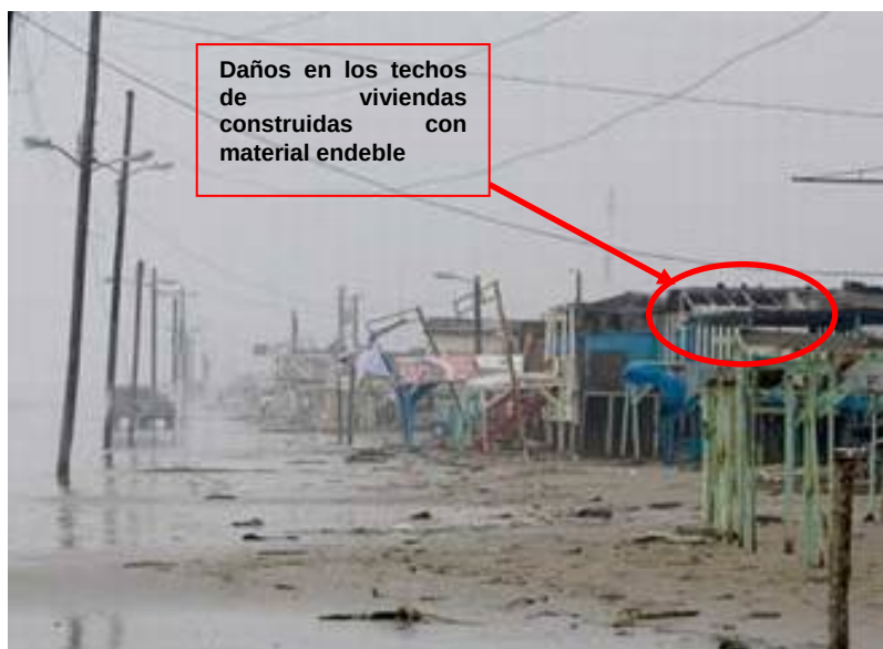
Figura 2.18 Algunas viviendas de material endeble perdieron sus techos a consecuencia del fenómeno
