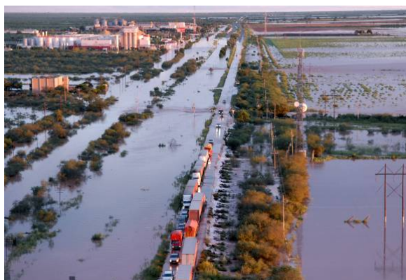
D. Anegamiento de la carretera que comunica el sur de Sonora con Guaymas
