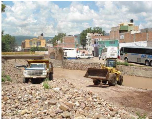
Figura 2.67 Acciones de desazolve y rectificación del cauce del río Xaloco en Tlaltenango
