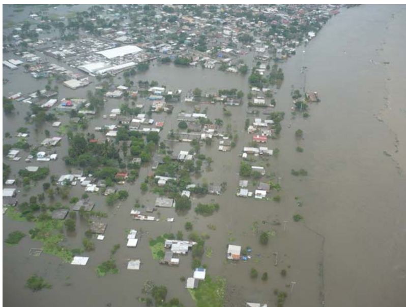
Figura 2.102 Vista aérea de la ciudad de Minatitlán en la que se puede apreciar un gran número de viviendas afectadas
