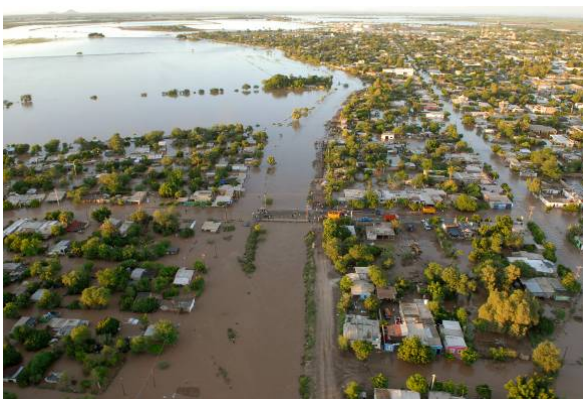
A. Inundación en la cabecera municipal de Huatabampo
