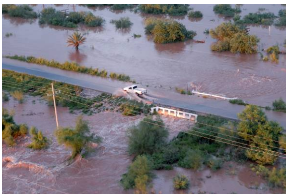
C. Flujo de agua por encima de un puente carretero debido a la inundación en la comunidad de Navojoa
