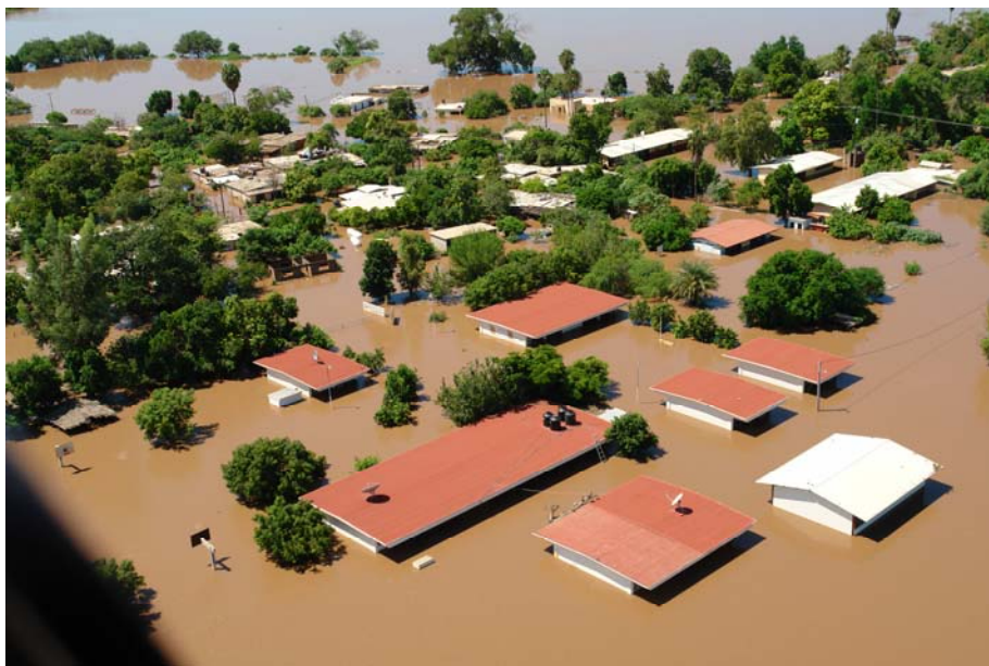
Figura 2.84 Escuelas primarias inundadas Huatabampo a causa de Lowell
