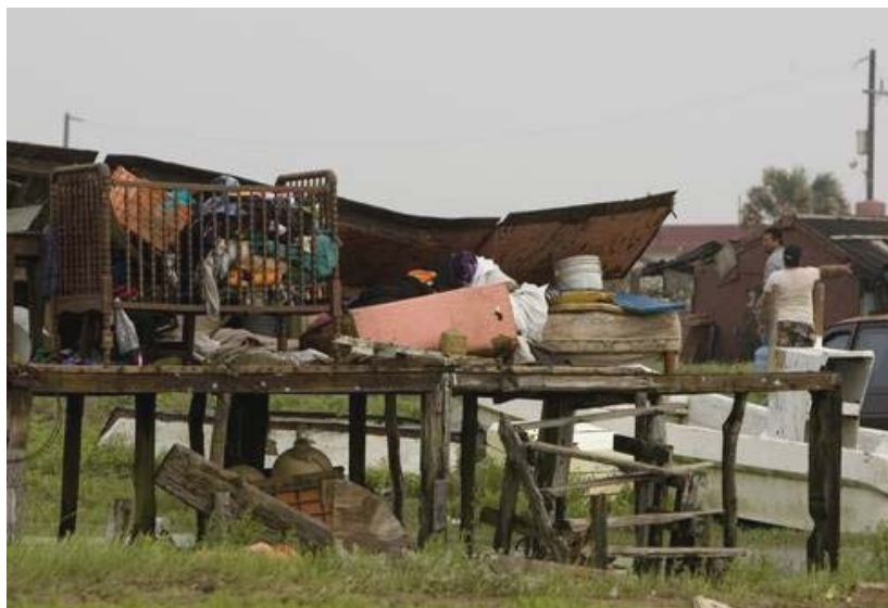
Figura 2.19 Daño total en una vivienda y pérdida de su menaje en la localidad de Playa Bagdad en el municipio de Matamoras
