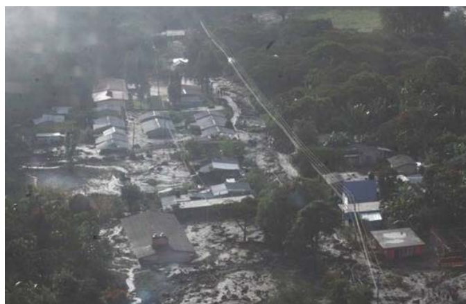
Figura 3.2 Imágenes del deslizamiento ocurrido en el municipio de Ixhuacán de los Reyes, Veracruz
