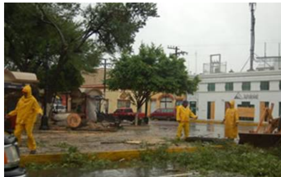
Figura 2.26 Limpieza de calles y árboles caídos
