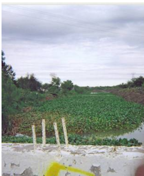
Figura 2.23 Dren azolvado por falta de mantenimiento
