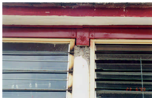
Figuras 7.36 y 7.37 - Muro y detalle del anclaje de la techumbre en la fachada sur del cuerpo D
