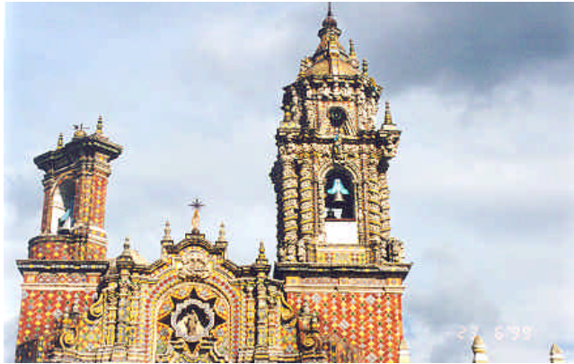
Figura 5.87 - Detalle de la fachada
