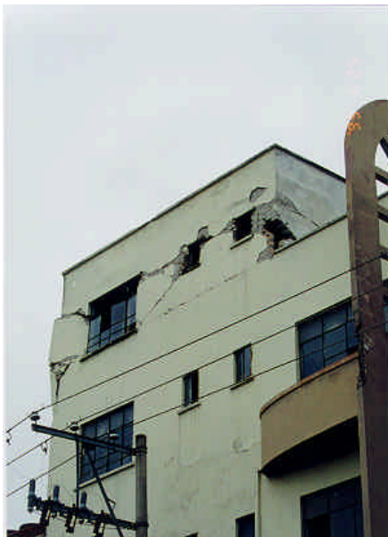
Figuras 8.20 y 8.21 - Vista del daño en apéndice y detalle del golpeteo entre edificios
