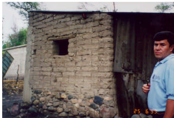
Figuras 6.44 y 6.45 - Grieta vertical en la intersección de muros y daño en el muro con abertura
