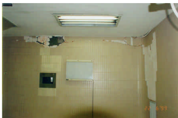
Figuras 4.16 y 4.17 - Daño no estructural en cubo de escaleras y zona de quirófanos
