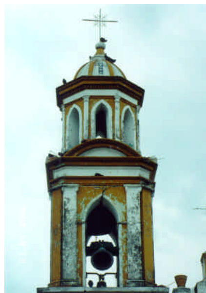
Figuras 5.17 y 5.18 - Fachada de la Iglesia de San José Victoria y daño en el campanario, aparentemente previo al sismo
