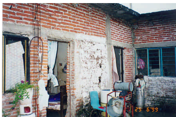
Figuras 6.25 y 6.26 - Detalle del cambio de material de construcción en muros
