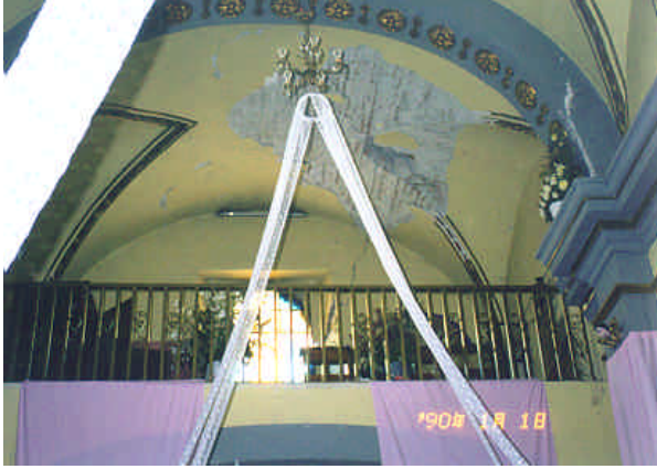
Figuras 5.7 y 5.8 - Daño en la bóveda (zona de colapso del campanario) y detalle de la falla y daño en la torre frontal izquierda
