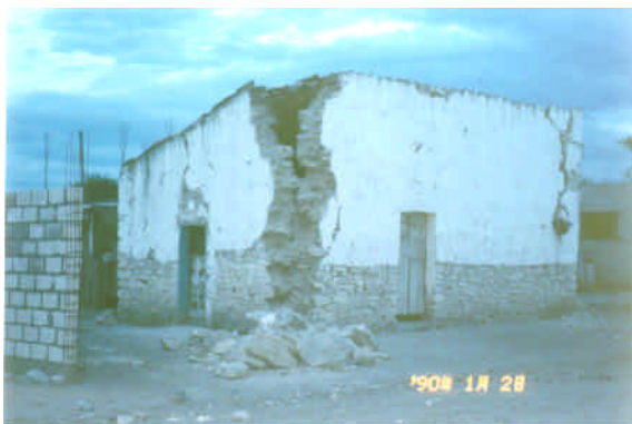
Figuras 6.57 y 6.58 - Agrietamientos verticales en unión perpendicular de muros y colapso total de una vivienda
