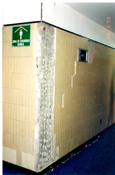
Figuras 4.2 y 4.3 - Vista general del Hospital San José y columna de segundo nivel, sin recubrimiento
