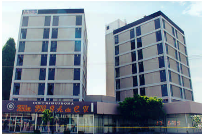
Figura 8.1 - Conjunto de edificios de oficinas
