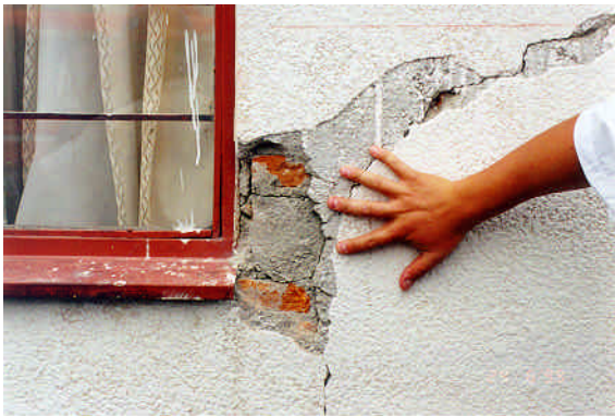
Figuras 6.11 y 6.12- Agrietamiento en elementos confinantes y en las esquinas de aberturas (eje A)
