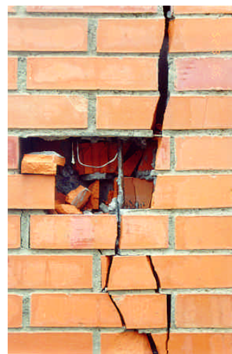
Figuras 6.17y 6.18 - Daño típico en el muro del eje 3 de la fachada y castillo interno donde no llegó la mezcla de concreto
