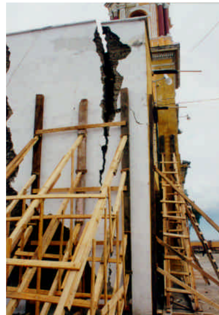
Figuras 5.80 y 5.81 - Colapso del apéndice derecho y apuntalamiento del izquierdo
