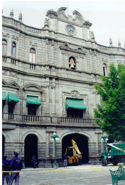
Figura 5.64 - Fachada del Palacio Municipal
