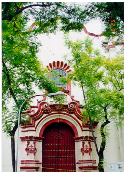
Figura 5.112 - Vista frontal de la Iglesia del Carmen
