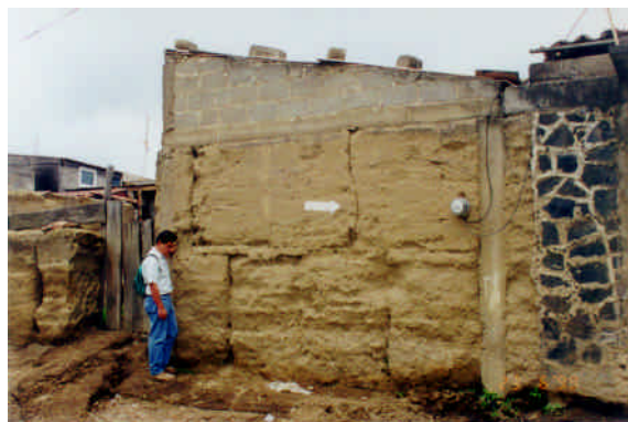
Figura 6.48 - Muro de tapia confinado, sin daño
