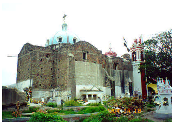
Figura 5.6 - Vista panorámica posterior de la Iglesia de San Antonio de Padua
