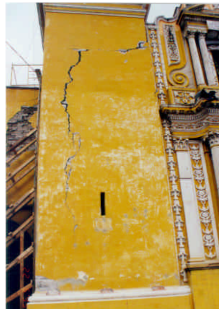
Figuras 5.78 y 5.79 - Agrietamiento inclinado y horizontal en torres de fachada
