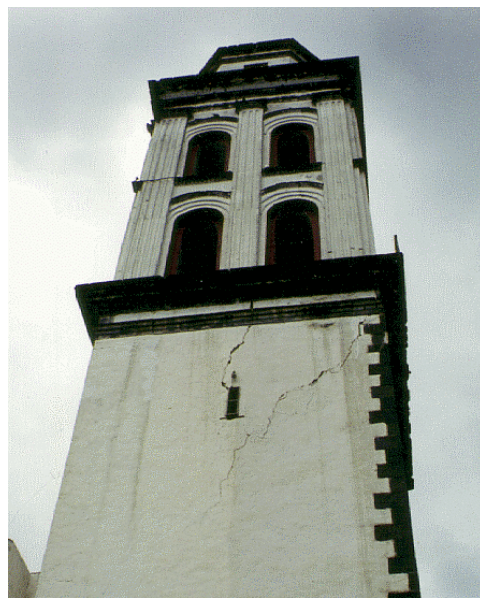
Figuras 5.45 y 5.46 - Parroquia del Padre Jesús y detalle del daño en la parte posterior de la torre
