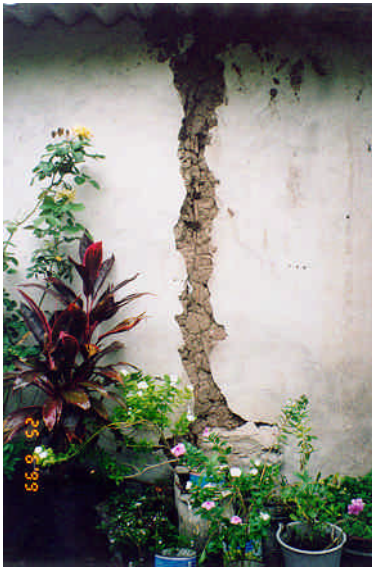
Figuras 6.21 y 6.22 - Daño en la intersección de muros y por movimientos fuera de su plano
