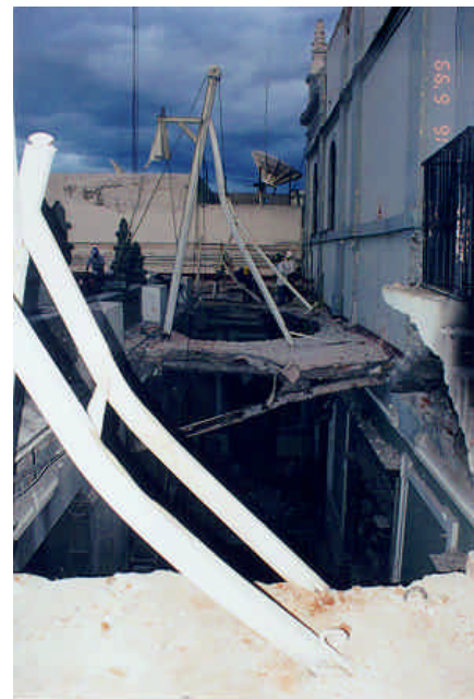
Figuras 5.65 y 5.66 - Almenas y balaustrada desplomadas; colapso de la losa del segundo nivel
