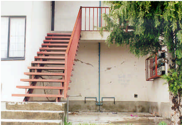
Figuras 6.6 y 6.7 - Daño en la planta baja y muros de fachada del edificio 001
