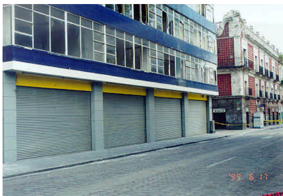
Figura 8.4 y 8.5 - Rotura de vidrios en fachada
