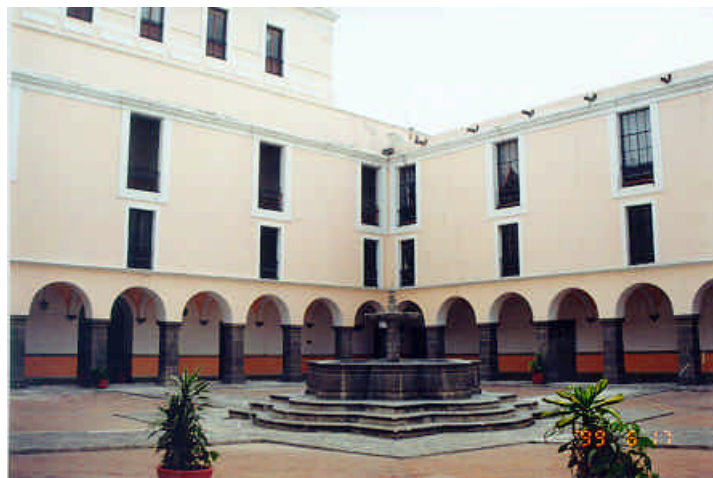
Figura 5.51 - Vista general del tercer patio del Edificio Carolino
