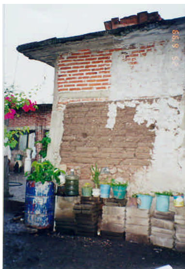
Figuras 6.25 y 6.26 - Detalle del cambio de material de construcción en muros
