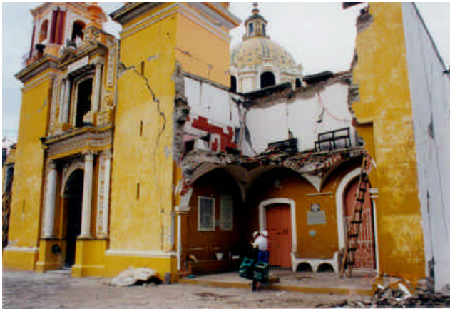
Figuras 5.80 y 5.81 - Colapso del apéndice derecho y apuntalamiento del izquierdo
