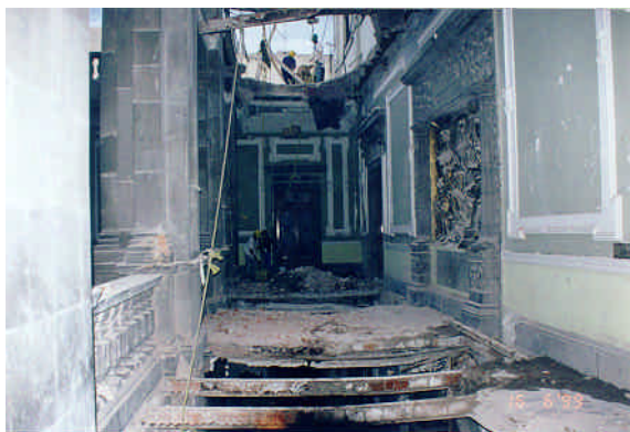
Figuras 5.67 y 5.68 - Detalle del sistema de piso del Palacio Municipal y estado del mismo
