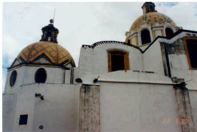
Figura 5.82 - Parte posterior de la iglesia, sin daño
