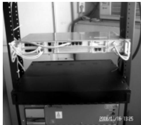
Switch central para la red datos del centro infraestructura de enlace redundante de 2MB
