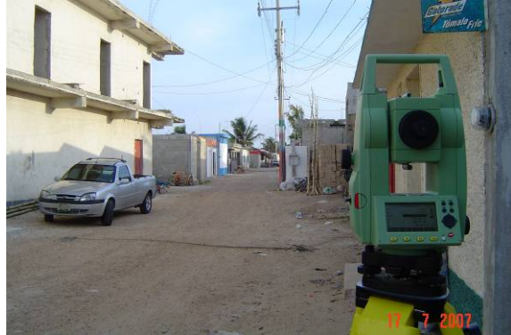
Figura 3.1 Levantamiento topográfico con “estación total”
