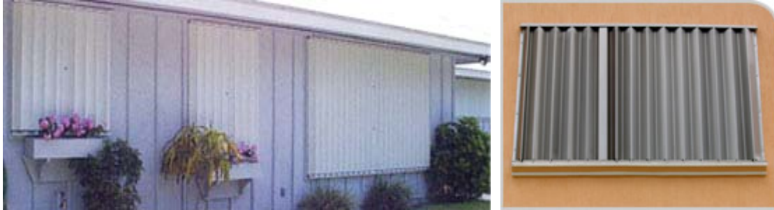
Figura 4.4. Ejemplos de cortinas anticiclónicas colocadas en las ventanas de las viviendas
