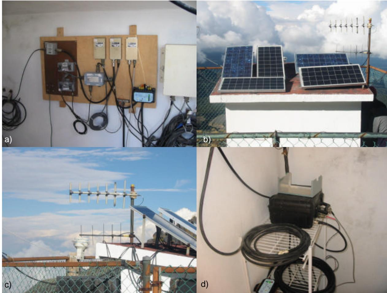
**Vista interior de la caseta de Canario: a) radios de telemetría, b) celdas solares
