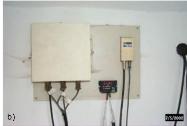
*Vista interior de la caseta de Tetexcaloc: a) vista general de los equipos, b) equipo acondicionador y radios de telemetría*
