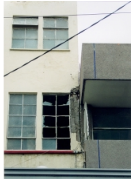
Figuras 8.20 y 8.21 - Vista del daño en ápndice y detalle del golpeo entre edificios
