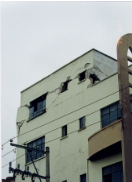
Figuras 8.20 y 8.21 - Vista del daño en ápndice y detalle del golpeo entre edificios
