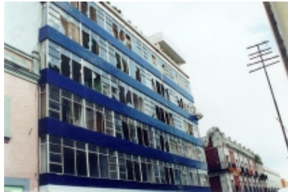
Figura 8.4 y 8.5 - Rotura de vidrios en fachada
