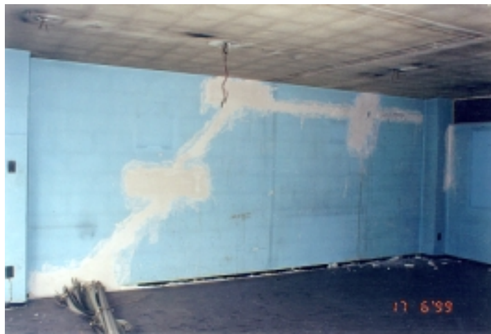
Figura 8.10 - Muros de mampostería resanados con yeso
