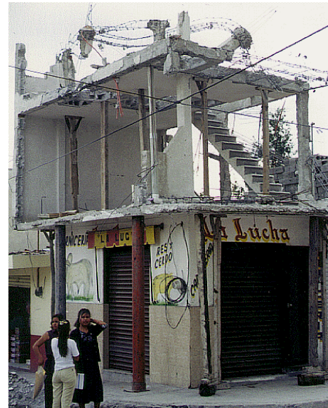
Figuras 8.11 y 8.12 - Estructura de vigueta y bovedilla antes y después de iniciar la demolición
