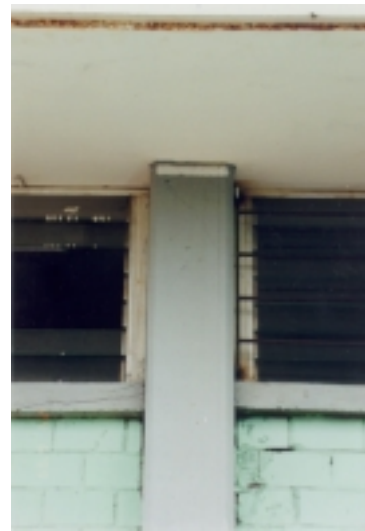
Figuras 7.15 y 7.16 - Detalle del daño en columnas del cuerpo C (fachada sur)
