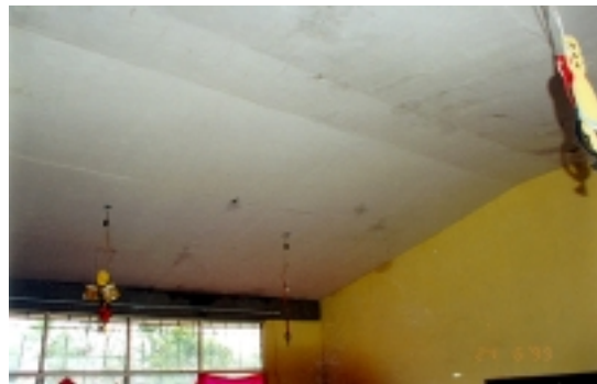
Figura 7.3 - Detalle de la losa de uno de los cuerpos
