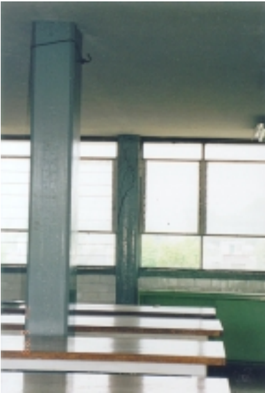
Figuras 7.19 y 7.20 - Columnas del cuerpo C sin confinamiento lateral
