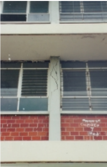
Figuras 7.15 y 7.16 - Detalle del daño en columnas del cuerpo C (fachada sur)
