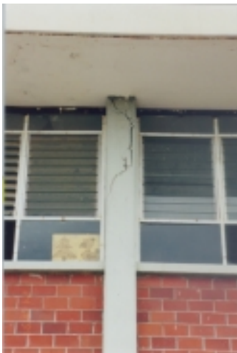
Figuras 7.13 y 7.14 - Detalle del daño en columnas del cuerpo C (fachada sur)
