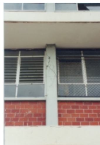
Figuras 7.13 y 7.14 - Detalle del daño en columnas del cuerpo C (fachada sur)
