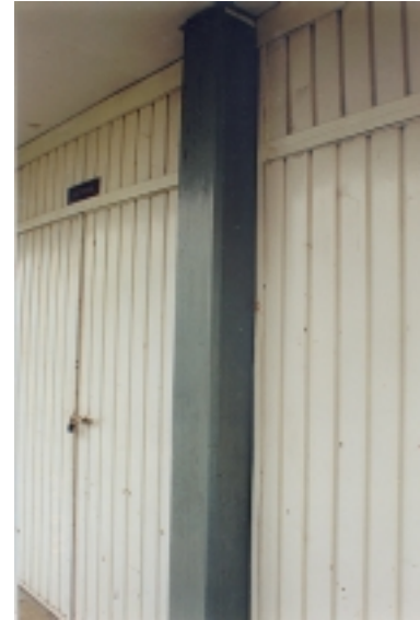
Figuras 7.19 y 7.20 - Columnas del cuerpo C sin confinamiento lateral
