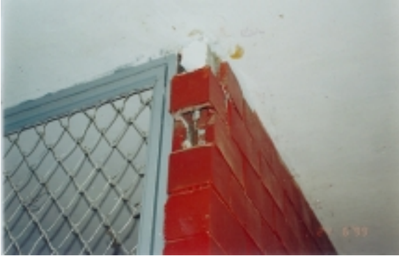
Figuras 7.23 y 7.24 - Castillo interno sin rellenar y falta de mantenimiento en una de las torres de escaleras
