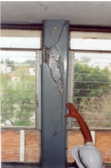
Figuras 7.17 y 7.18 - Detalle del daño en una columna del cuerpo C (fachada sur)
