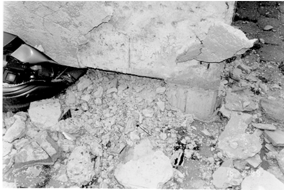
Figura 3.6 - Penetración en el terreno de una columna de esquina
